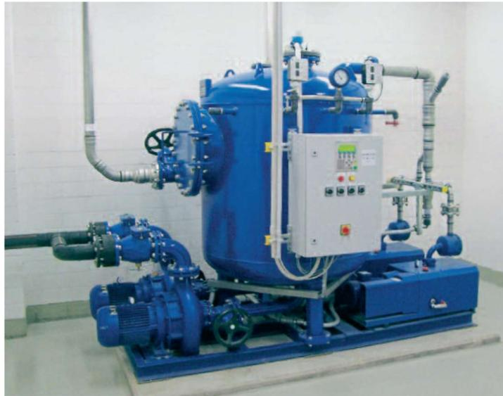
La centrale del vuoto dovrà essere resa pronta per il funzionamento inclusi quindi tutti i collegamenti alle reti di scarico ed aspirazione, valvole di non ritorno, lift, tubi di ispezione, valvole divisorie.
