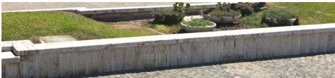
Locale tecnico interrato della centrale del vuoto - copertura
