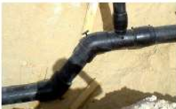
Tipica installazione per la formazione delle tasche di trasporto
