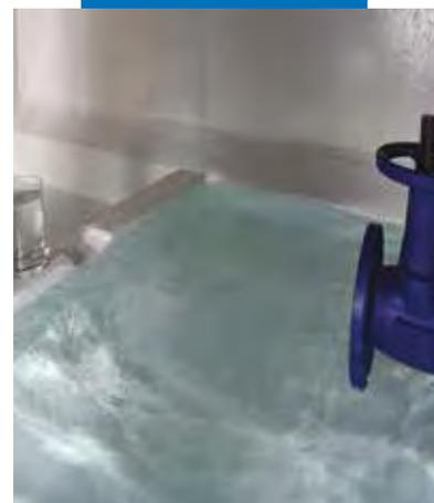
Riempimento della vasca dopo l'indurimento completo di Mapecoat DW 25
