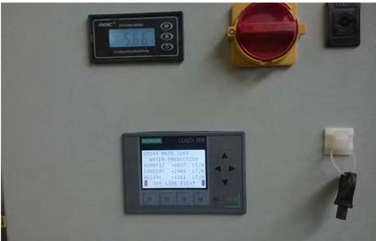
Esempio di quadro elettrico di ns. osmosi inversa con PLC Siemens e pannello operatore
