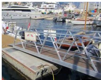
N.B. La lunghezza delle passerelle, in linea con il disegno di progetto, risulta ridotta rispetto a quella di accesso al molo a T per limitare l'ingombro sui pontili e la conseguente difficoltà di accesso ai primi posti barca in prossimità della banchina. La pendenza sarà quindi più elevata, e risulterà del 18% sul livello medio mare
