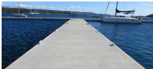
Il piano di calpestio è in calcestruzzo a vista con finitura antisdruciuolo. Il fondo di ogni manufatto sarà trattato con speciale rivestimento protettivo ad elevato spessore. L'elevatissimo dislocamento e la rilevante larghezza al galleggiamento pari a 4,5m assicurano un'eccezionale stabilità in acqua.
