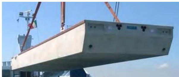
Ogni elemento sarà dotato sui due lati di tubazioni in PVC di diversi diametri, annegate nel getto, per l'inserimento delle reti tecnologiche. Ciascun elemento sarà dotato di n.2 pozzetti per agevolare l'installazione delle reti tecnologiche.
