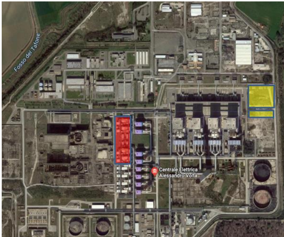
Figura 2.2 – Ortofoto della centrale con indicazione dei gruppi da sostituire (in rosso)
