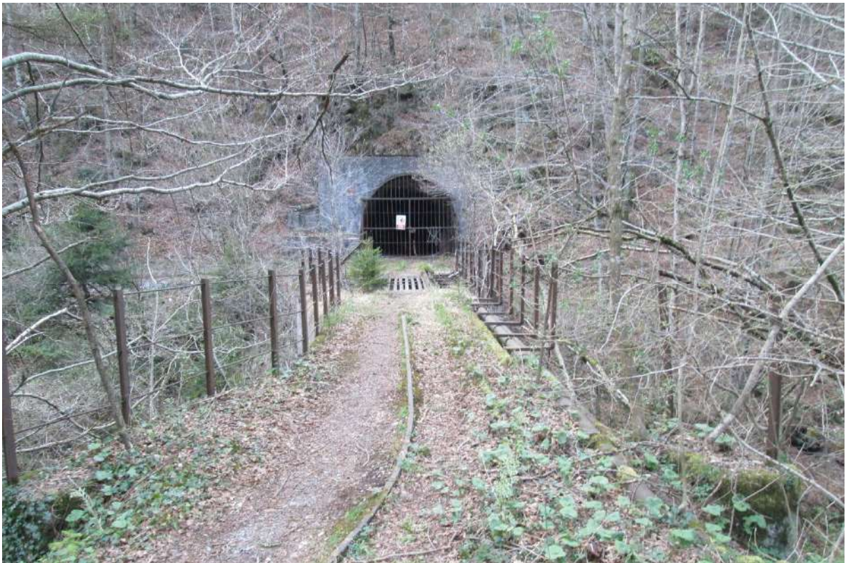
Il ponte sul Torrente Vedra che dà accesso alla galleria Forcella che, insieme alla strada di accesso, è stato oggetto di sistemazione, e che costituirà la via di ingresso anche per raggiungere le gallerie artificiali ove effettuare le operazioni programmate nel 2020-22 per il permesso "Cime".
