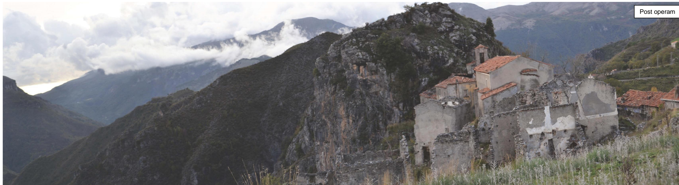
Figura 2-9: Fotoinserimento della linea Rotonda- Palazzo 150 kV nei pressi del Borgo antico di Avena
