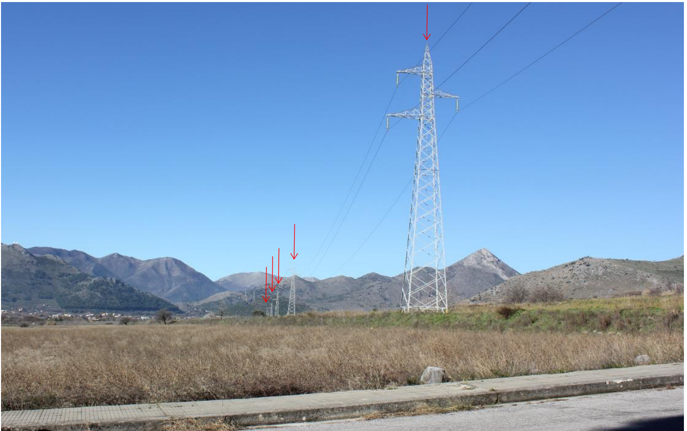
Figura 3-9: Vista fotografica dell'area nei pressi della CP di Castrovillari che ritrae la linea Rotonda-Terranova-Mucone 220 kV che sarà oggetto di demolizione nell'Alternativa B ottimizzata ricadente in un'area di interesse archeologico
