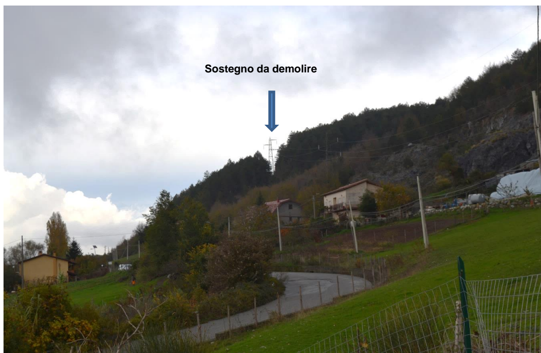
Figura 2-1: Vista fotografica della linea "Rotonda-Palazzo 150 kV"
