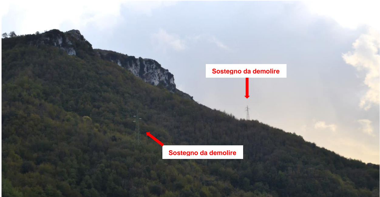
Figura 2-3: Vista delle Rupi in prossimità della linea "Rotonda Palazzo 150 kV"
