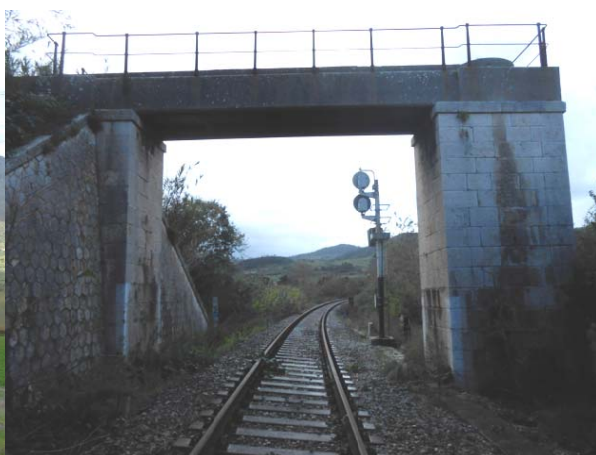
prog. km 81+994 – ponte canale
