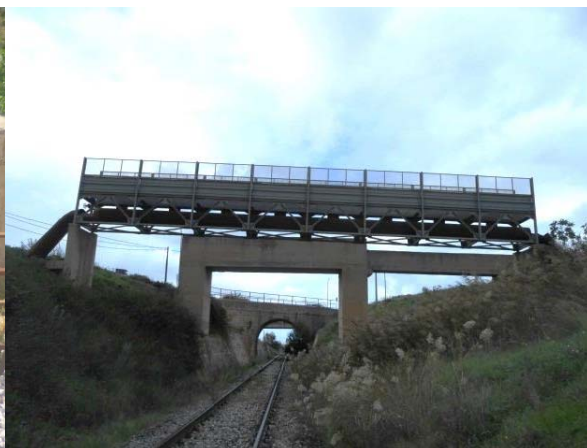
prog. km 115+175 e 115+185 ponte tubo e ponte canale
