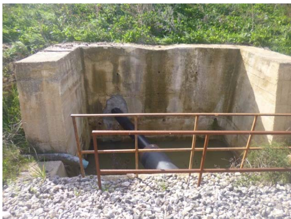
prog. km 112+860 – acquedotto o irriguo
