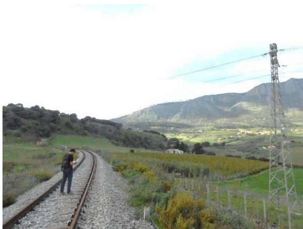
prog. km 75+720 – linea aerea
