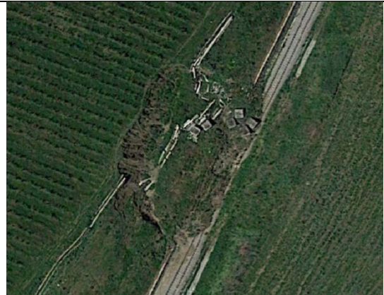
foto aerea del dissesto del tratto in trincea
