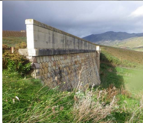
Prospetti di muri esistenti –tipologici dei nuovi rivestimenti
