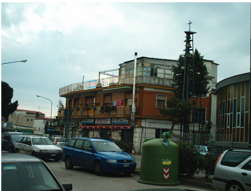
Figura 14 – Elementi isolati posti a bordo strada
