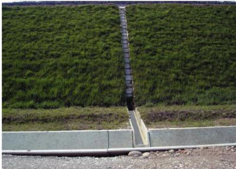
Figura 3.5 - Foto rappresentativa di rilevato ferroviario con embrice e scarico in fosso di guardia rivestito in cls
