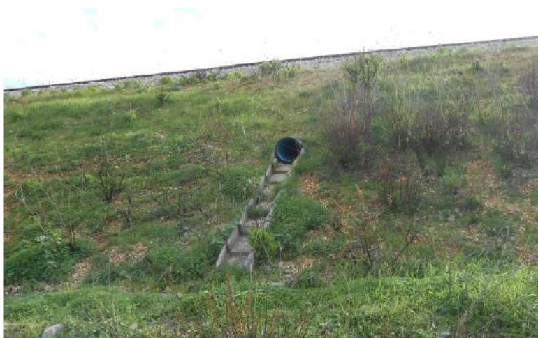
Figura 3.4 - Foto rappresentativa di rilevato ferroviario con embrice e scarico in fosso di guardia rivestito in cls
