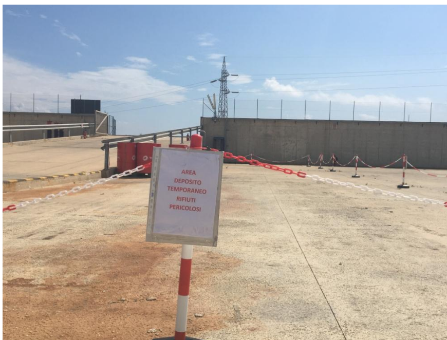
Area deposito temporaneo rifiuti pericolosi
