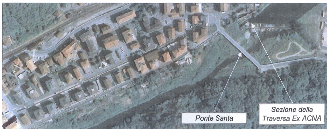
Figura 5-3 - Vista del punto di monitoraggio della stazione idrometrica su Traversa Ex-ACNA
