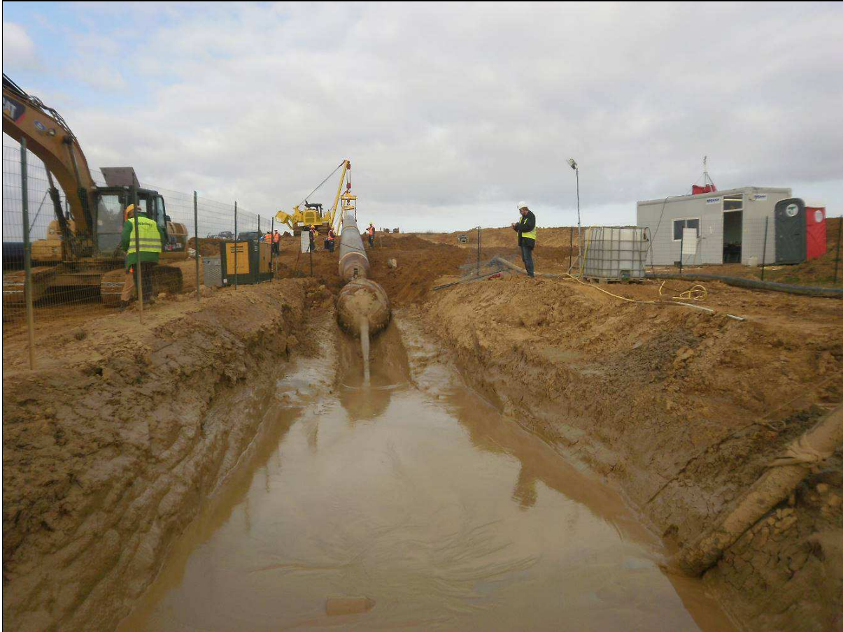
Fig. 2.8 - Fase di “tiro – posa della condotta”.
