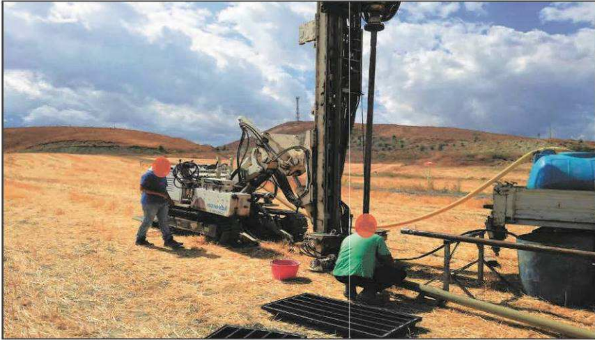
Foto n. 01 – Ubicazione sondaggio S3
