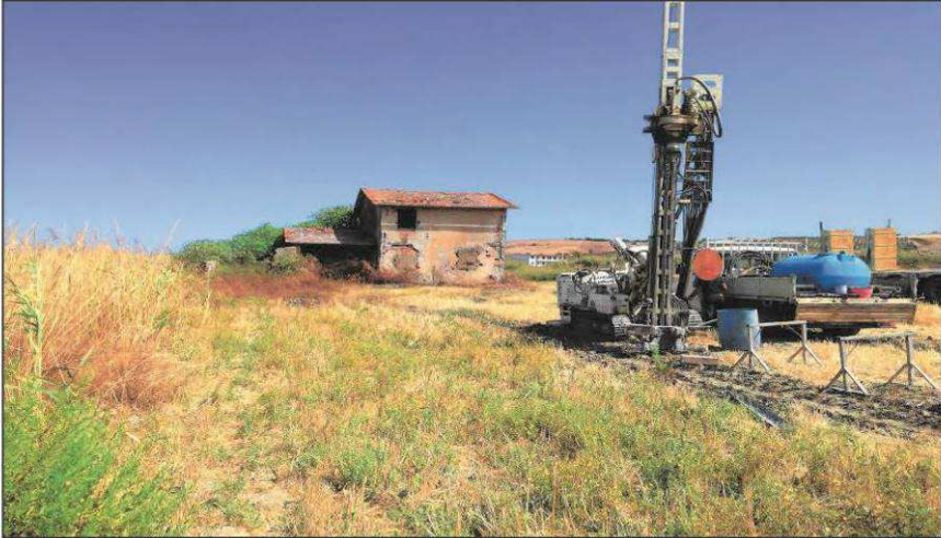
Foto n. 01 – Ubicazione sondaggio S1
