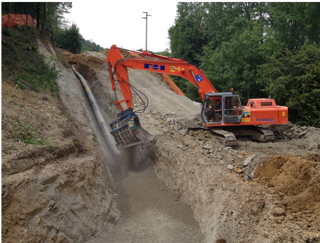
Fig. 9.3 - Operazione di rinterro della condotta.
