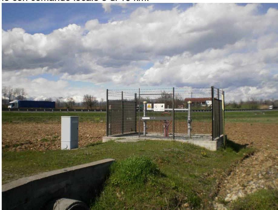
**Fig. 8.2 – Esempio di impianto di intercettazione di linea PIL.**
