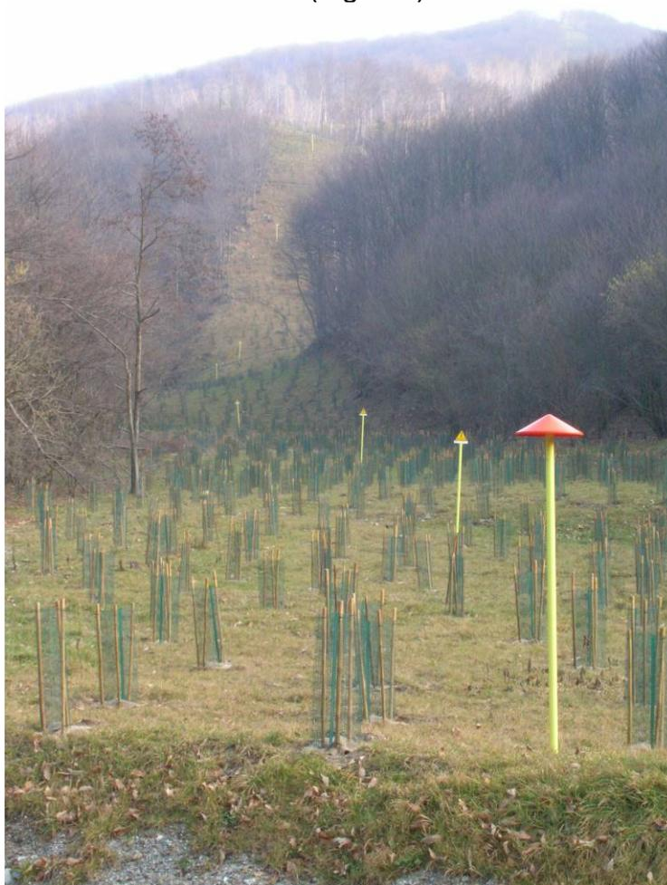
Fig. 9.8 - I cartelli segnalatori di un metanodotto posizionati lungo il tracciato.
