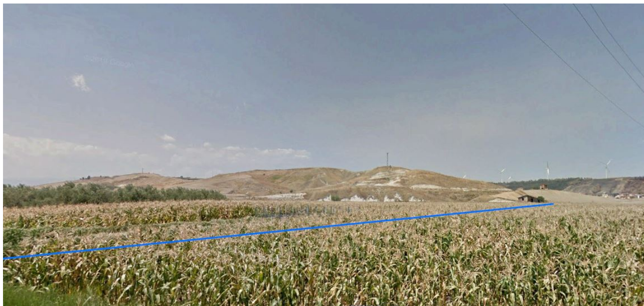
Fig. 5.75 – tracciato del metanodotto esistente (in blu) a poca distanza dall'area di intervento.
