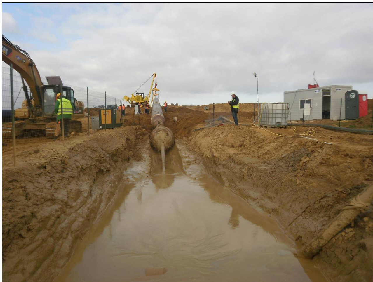
Fig. 3.12 – Fase di “tiro – posa della condotta”.
