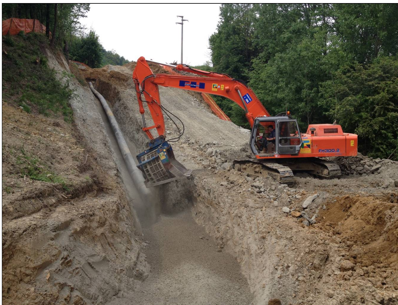
Fig. 3.8 - Operazione di rinterro della condotta.
