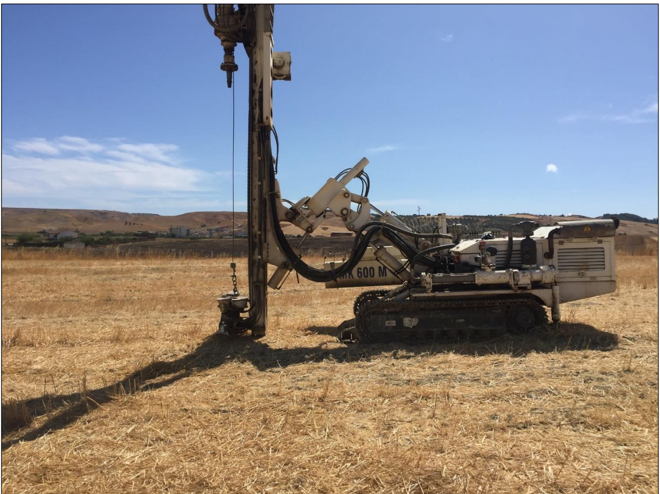
Fig. 6.1 - Sondaggio geognostico in corso.
