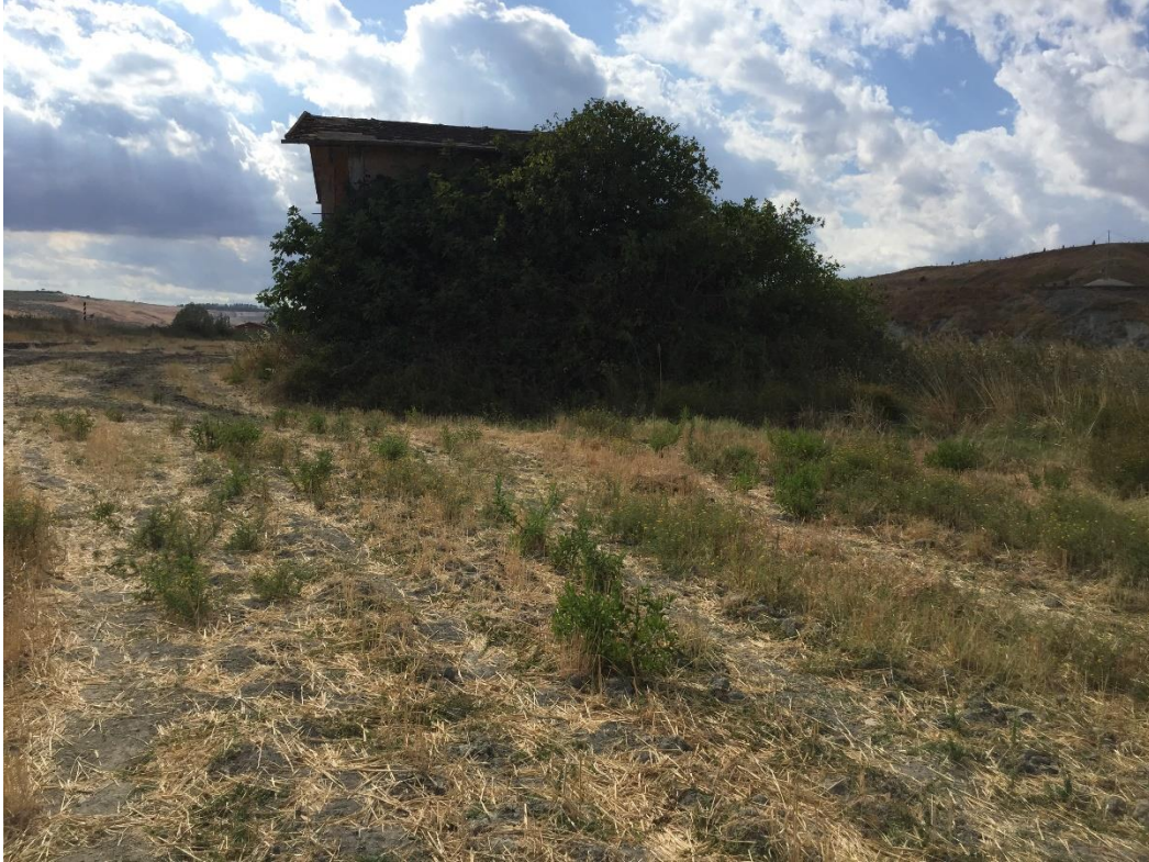
Foto 13 – Panoramica UT 04 – Vista E-W
