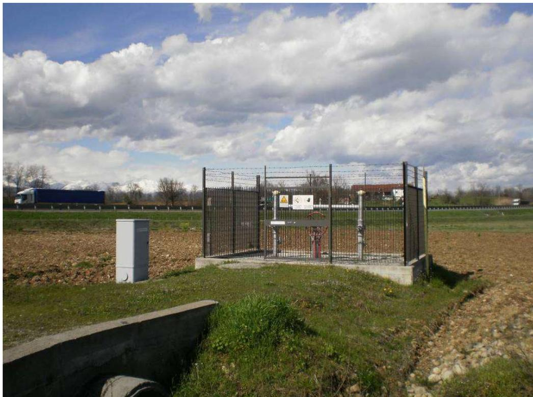
**Fig. 4.1 – Esempio di impianto di intercettazione di linea PIL.**
