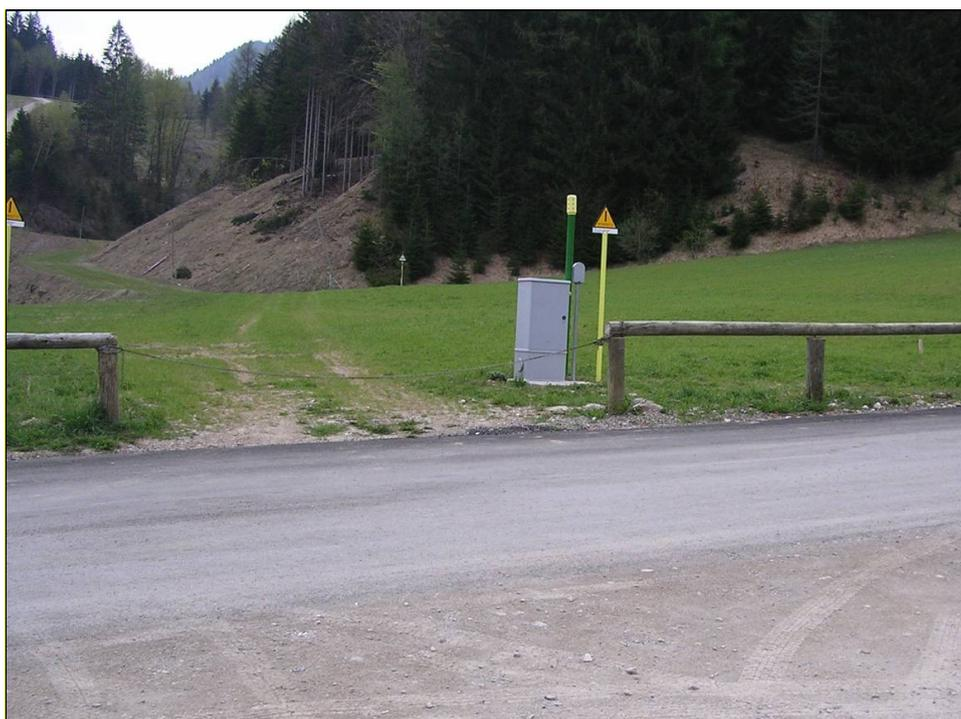
**Fig.5.3 - I cartelli segnalatori del metanodotto ed i tubi di sfiato posti in corrispondenza degli attraversamenti eseguiti con tubo di protezione.**
