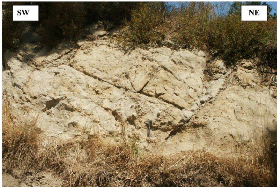
Figura 363 Area dell'ammasso roccioso oggetto dell'acquisizione dei dati geomeccanici, stratificazione
