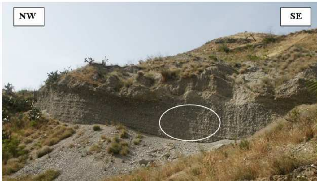
Figura 80 Area dell'ammasso roccioso oggetto dell'acquisizione dei dati geomeccanici
