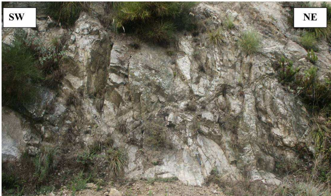
Figura 505 Area dell'ammasso roccioso oggetto dell'acquisizione dei dati geomeccanici, stratificazione
