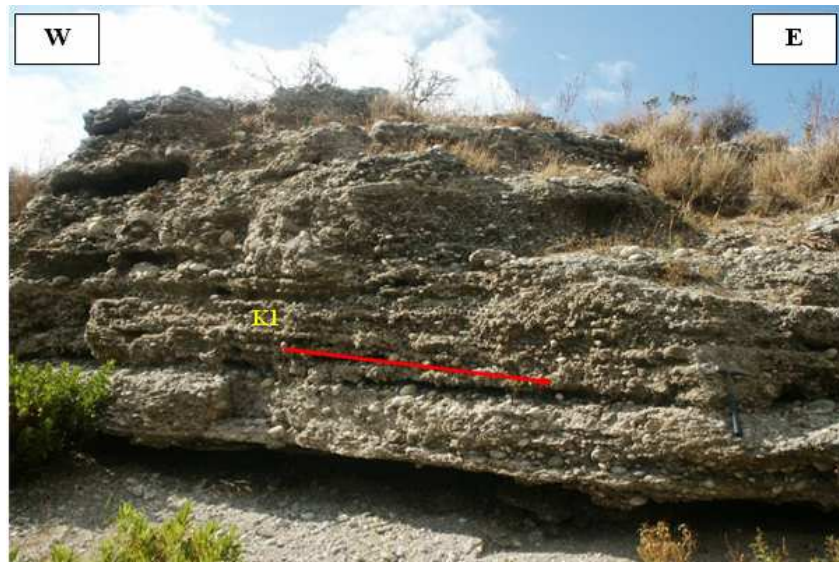
Figura 71 Area dell'ammasso roccioso oggetto dell'acquisizione dei dati geomeccanici, stratificazione
