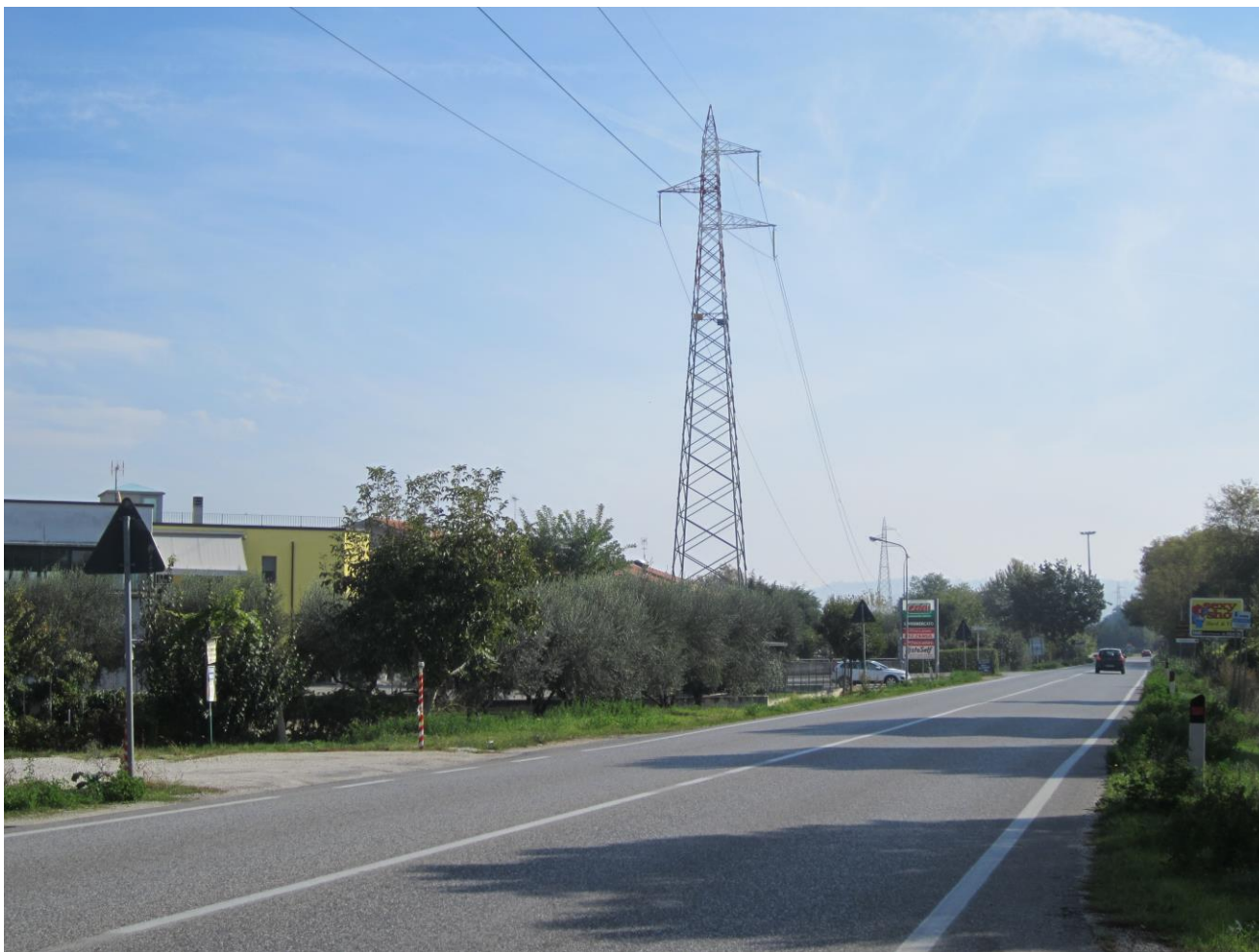
Figura 8 - Sostegno 75 oggetto di demolizione adiacente alle abitazioni
