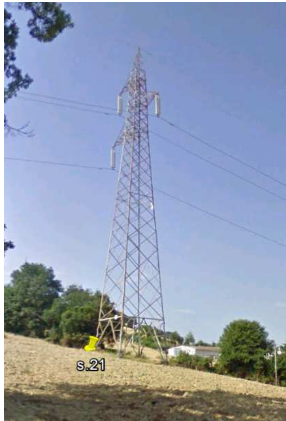
Sostegno di sospensione tipo - attuale dorsale 220kV
