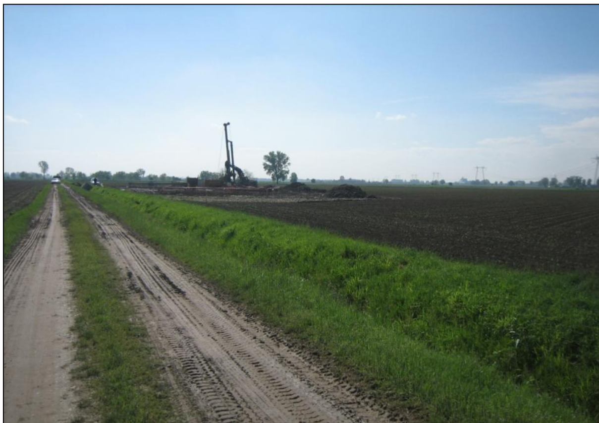
Figura 7-3 Esempio di micro cantiere con pista di accesso
