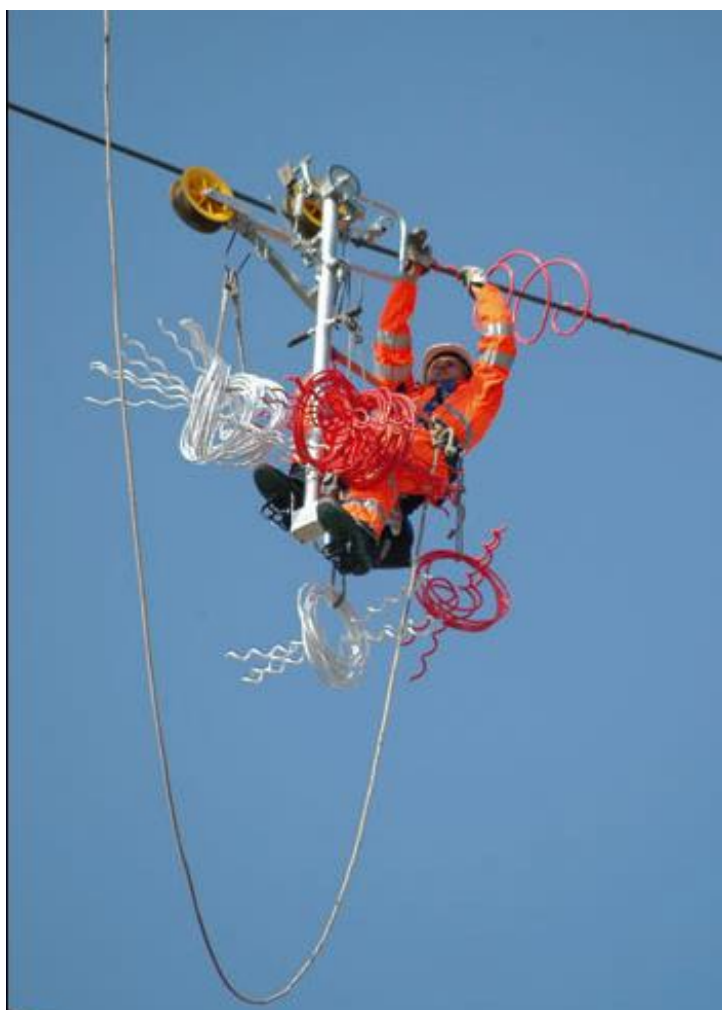
Figura 10-18 Montaggio dissuasori di segnalazione per avifauna
