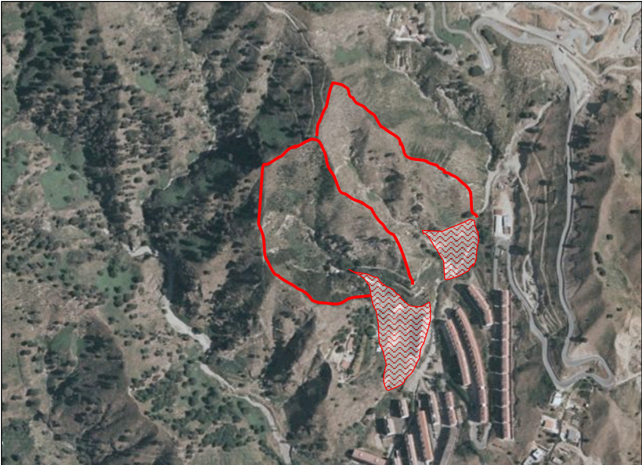
Fig. 8. Nella figura sono evidenziati due piccoli bacini, con i relativi coni alluvionali alla confluenza con la valle principale. E' possibile notare (strisce e macchie bianche) la diffusa presenza di erosione e dissesti che giustificano la presenza di cono relativamente grandi se rapportati alle aree di alimentazione.
