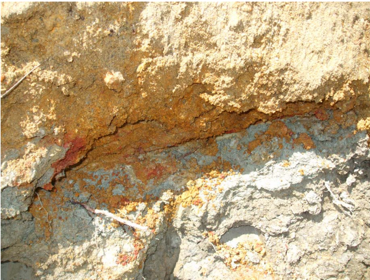
Fig. 10 – Dettaglio dell'appoggio del detrito di frana sulle argille tortoniane della Formazione di San Pier Niceto presso la scarpata posta alla testata dello scorrimento-colata.
