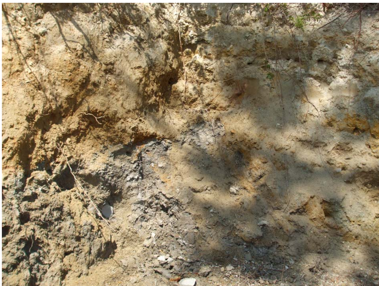
Fig. 9 – Affioramento di detrito di frana su argille tortoniane della Formazione di san Pier Niceto presso la scarpata posta alla testata dello scorrimento-colata.
