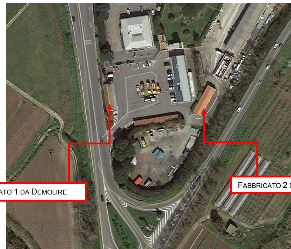
FIGURA 2-33. Il Posto di Manutenzione di ASPI, nella configurazione attuale, dove si prevede la Demolizione del Fabbricato 1, e la Riqualifica del Fabbricato 2
