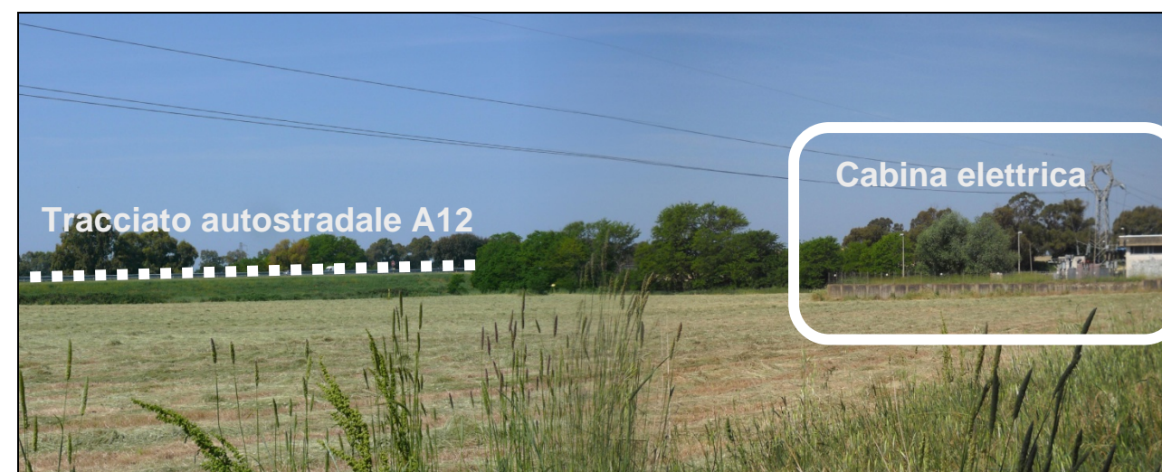
Figura 4-32 Centrale di produzione dell'energia elettrica. Rapporto dell'edificio ubicato sulla destra e il tracciato autostradale
