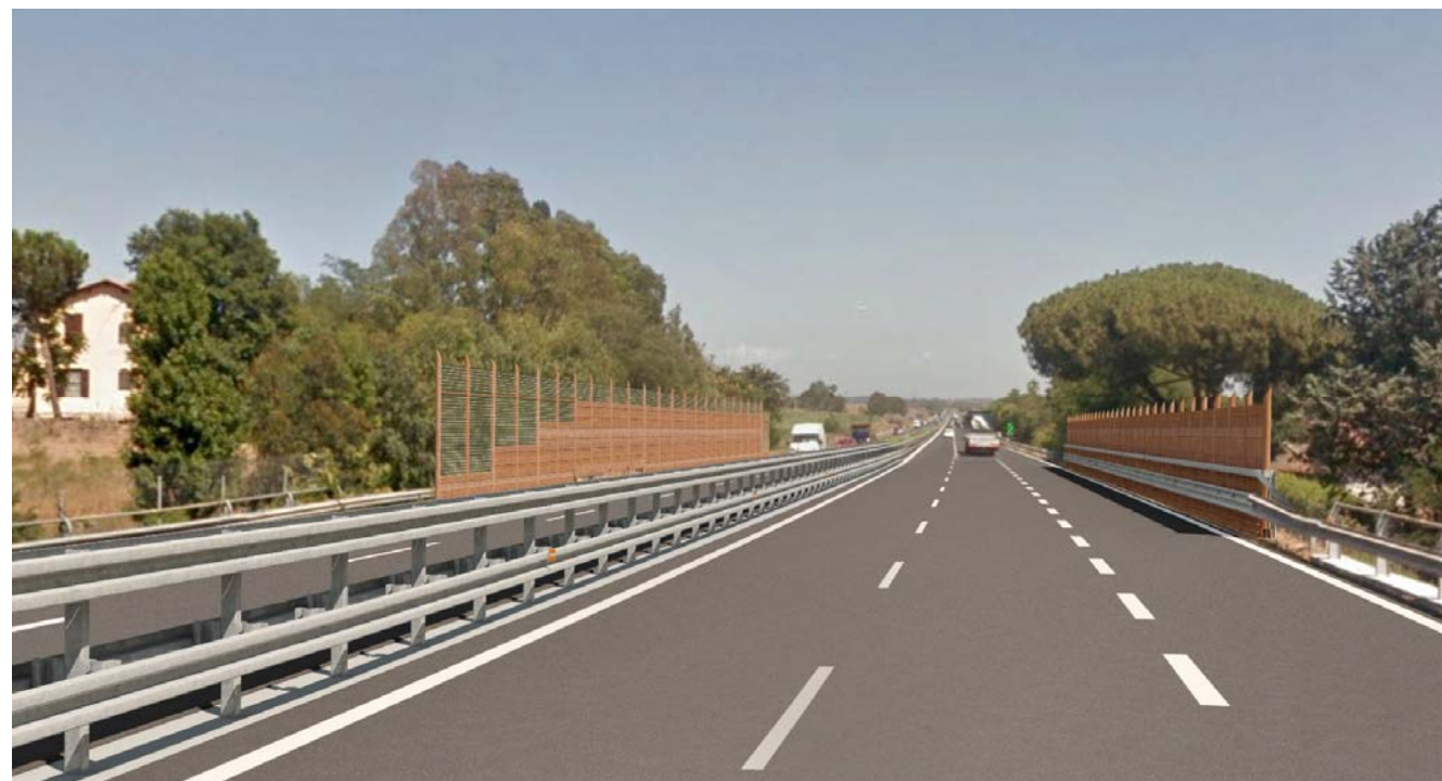
Figura 2-40: le barriere 1N ( h = 5 m, di cui i 3 m superiori sono trasparenti) e 3S (integrata opaca)
