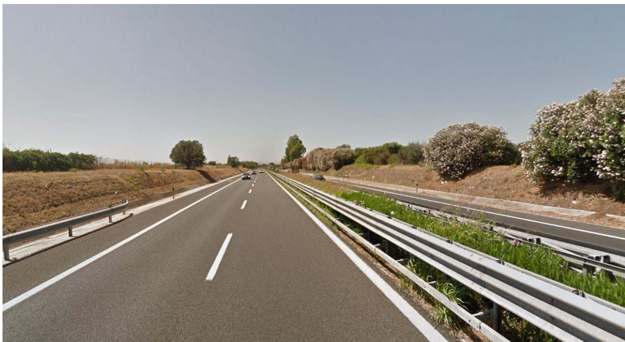
Figura 5-8: Corsia sud in prossimità di FOA 05S
