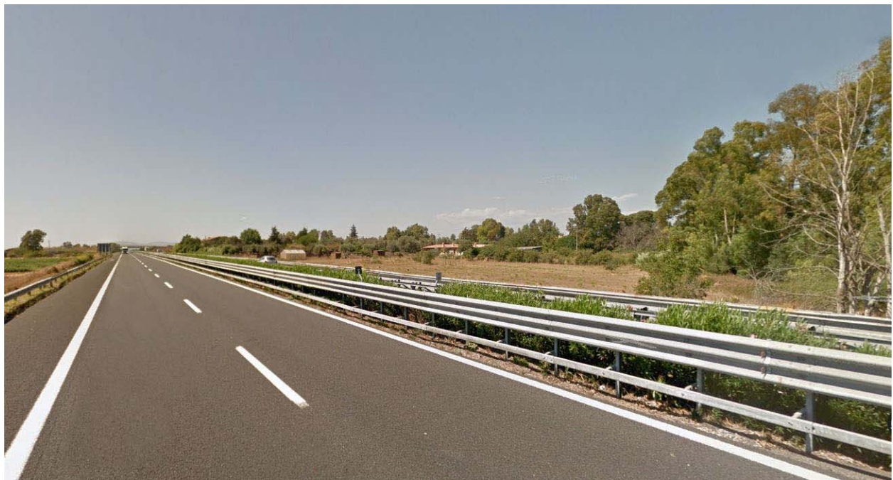
Figura 5-5: Corsia sud in prossimità di FOA 02N
