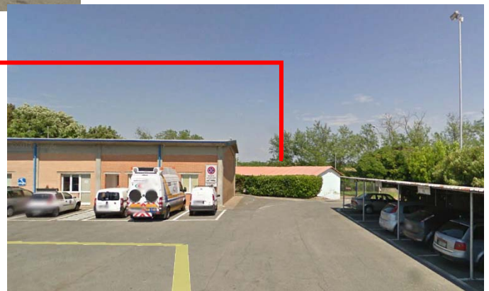
FABBRICATO 2 DA RIQUALIFICARE
