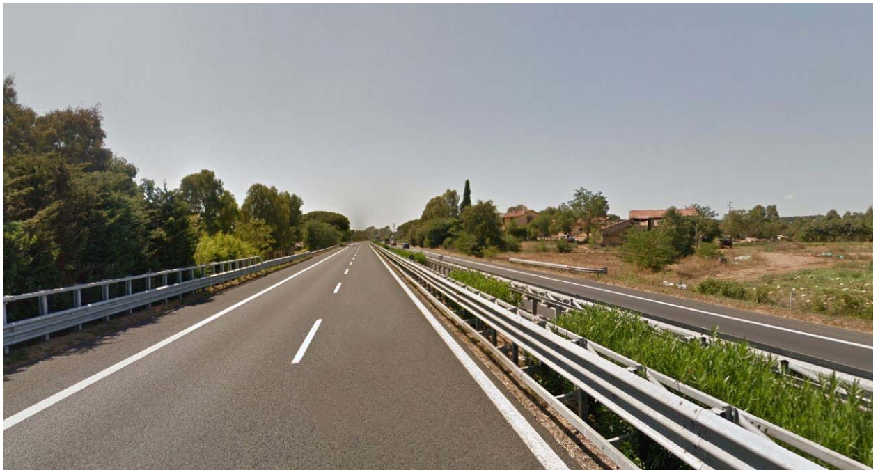
Figura 5-4: Corsia sud in prossimità di FOA 03S e FOA 01N
