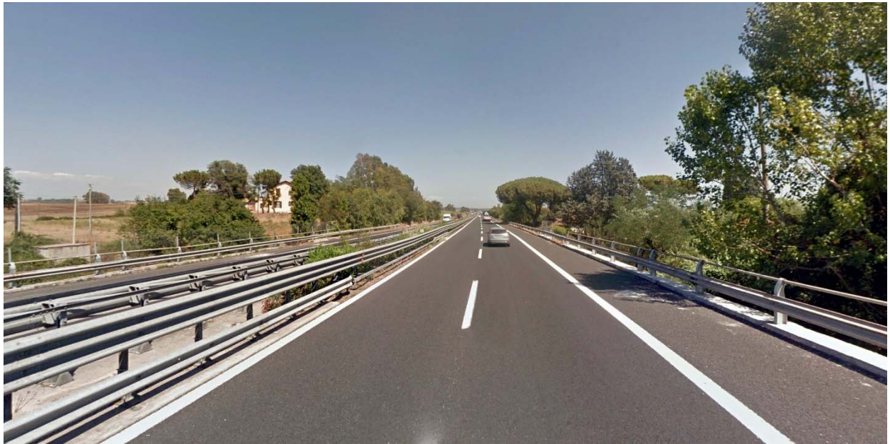
FOA 01N e 03S, vista 2, stato attuale
