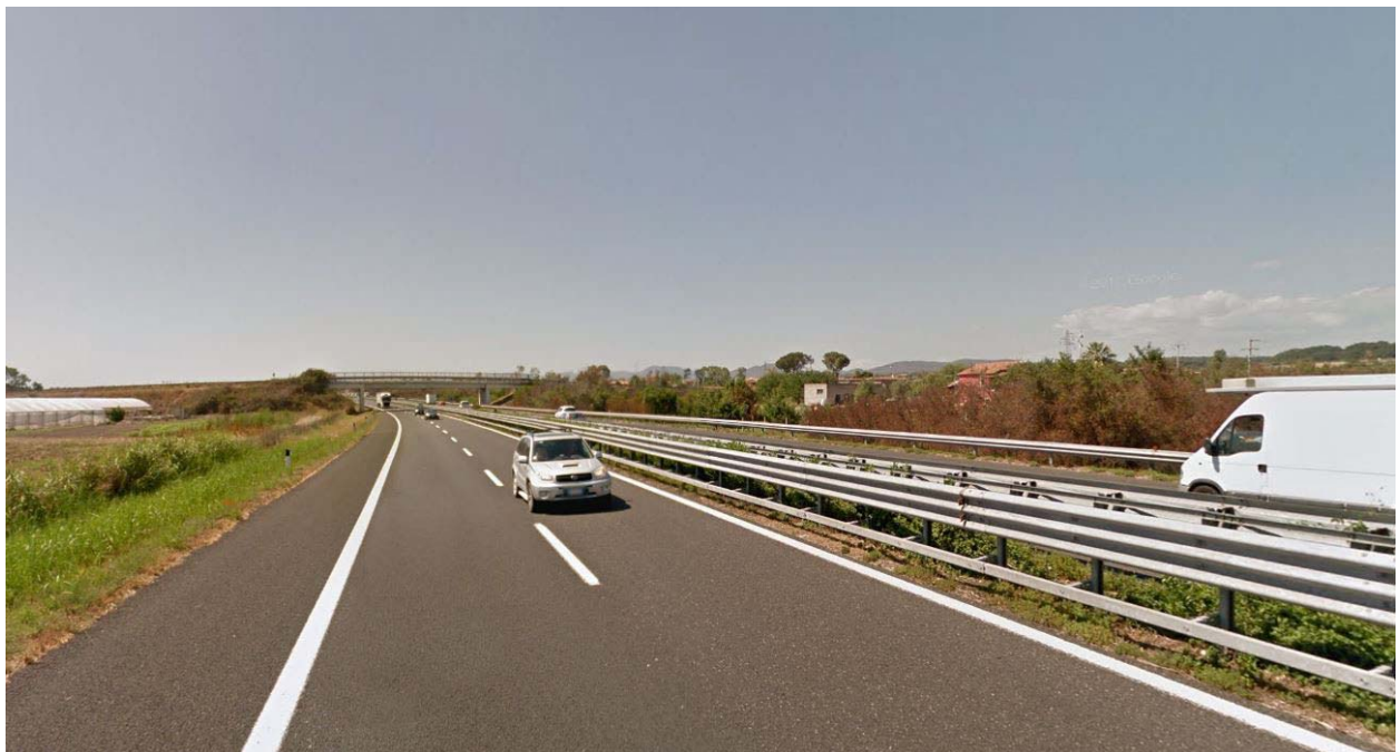
Figura 5-7: Corsia sud in prossimità di FOA 04-06N
