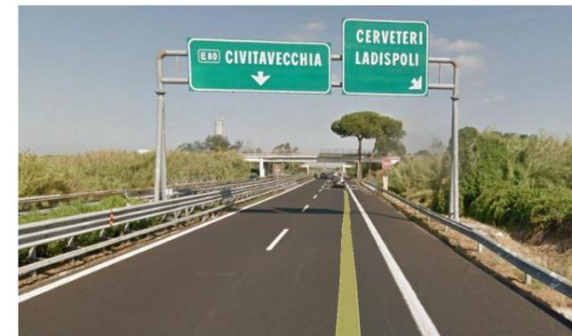
Figura 3-37. Portale esistente a cavalletto in carr. Nord da sostituire (km27+600)
