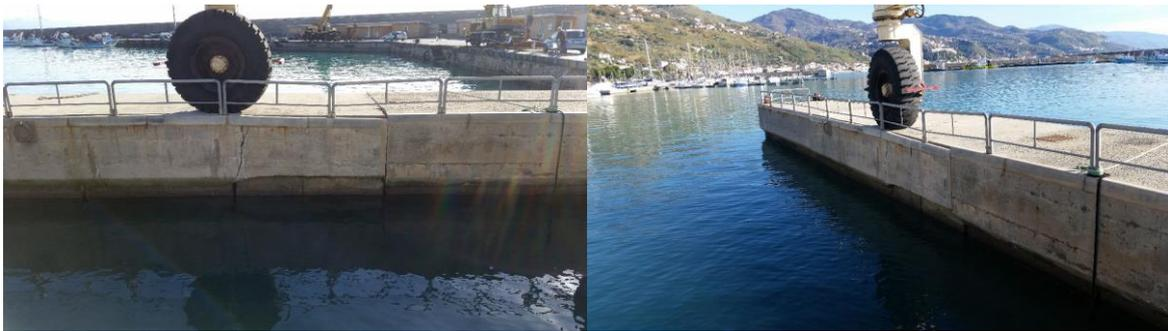
Figura 3-11 Cedimento via di corsa travel lift
