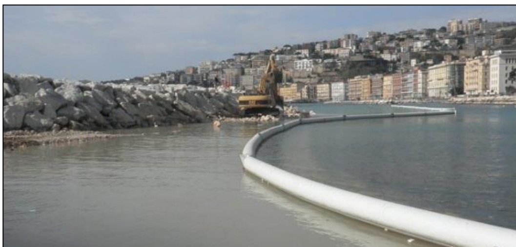
Figura 5-2 – Utilizzo di barriere anti-torbidità durante i lavori
