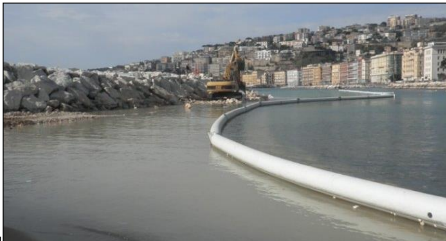
Figura 3-2 – Utilizzo di barriere anti-torbidità durante i lavori
