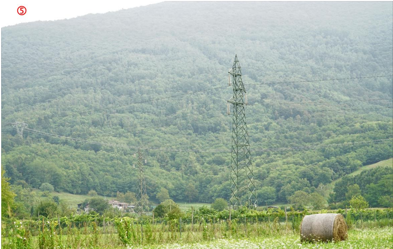
Fig. 7. Elettrodotto 123 su area agricolo-boschiva
