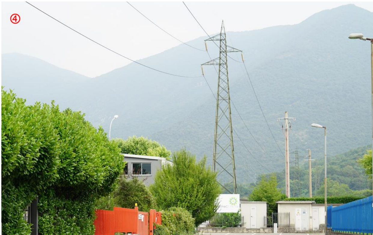
Fig. 6. Elettrodotto 123 su area industriale
