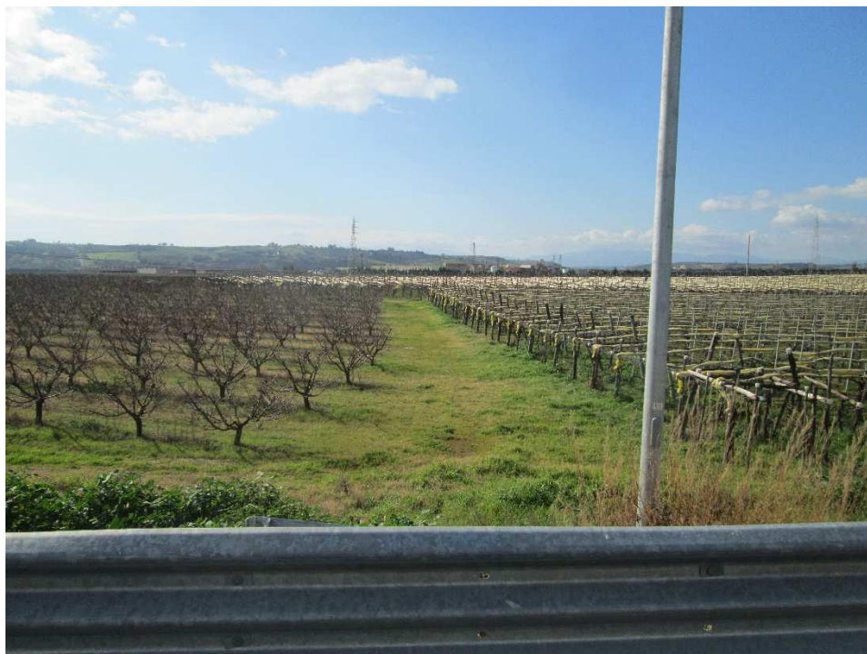
Vista 2 - Frutteti adiacenti al nuovo svincolo SV02, nei pressi della Rampa D e della rotonda. Sono stati installati i nuovi guardarail e l'impianto di illuminazione
