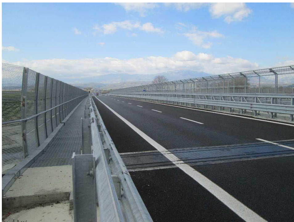
Vista 4 - Punto panoramico del Nuovo Viadotto Coscile. In primo piano si può vedere la carreggiata in direzione Sibari, i guardrail e le barriere di protezione
