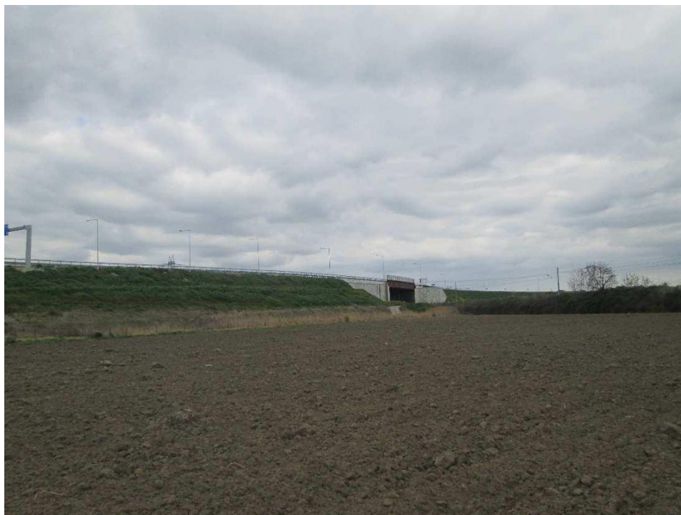
Vista 4 – Terre armate a tergo delle spalle, già rinverdite. L'area circostante mantiene la sua vocazione agricola
