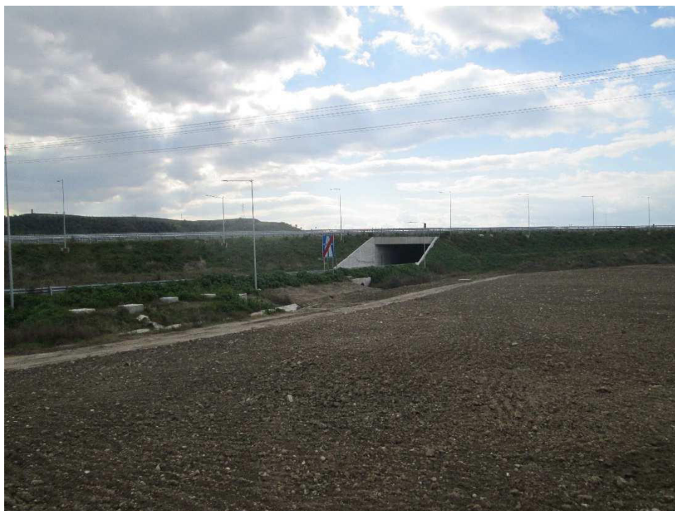
Vista 7 – Sottovia di nuova realizzazione presso lo Svincolo di Torre Mordillo
