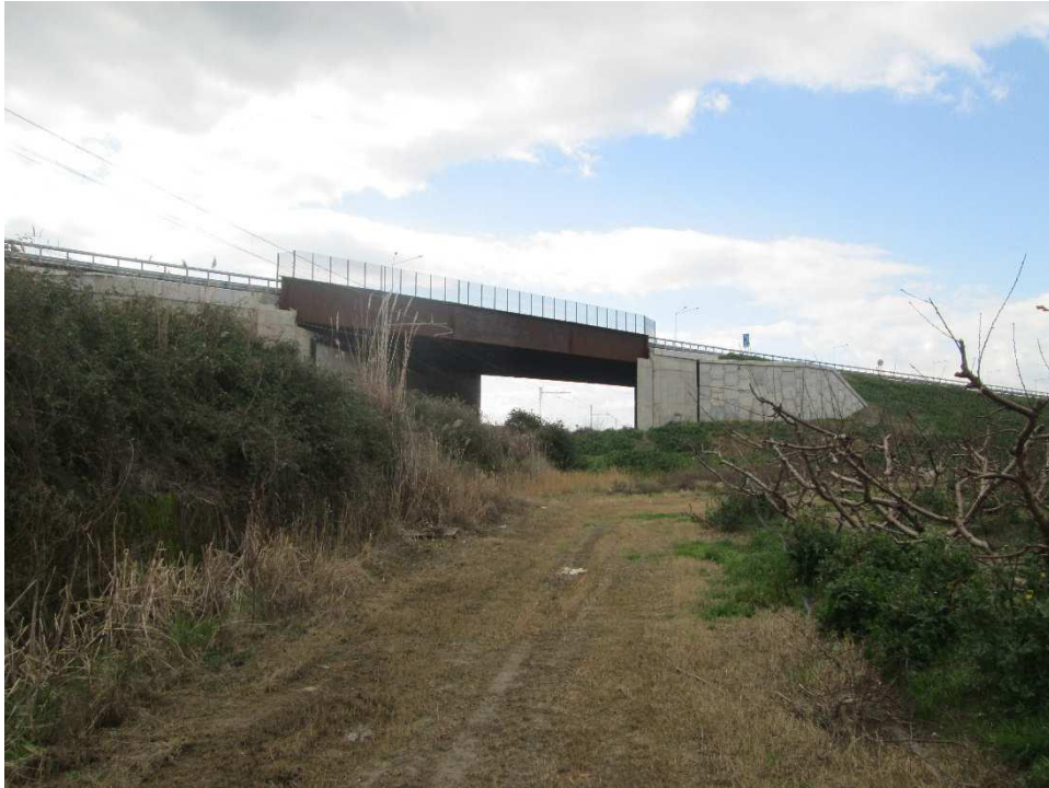
Vista 1 – Nuovo Cavalcaferrovia completo di barriere. A tergo delle spalle sono presenti le terre armate rinverdite.
