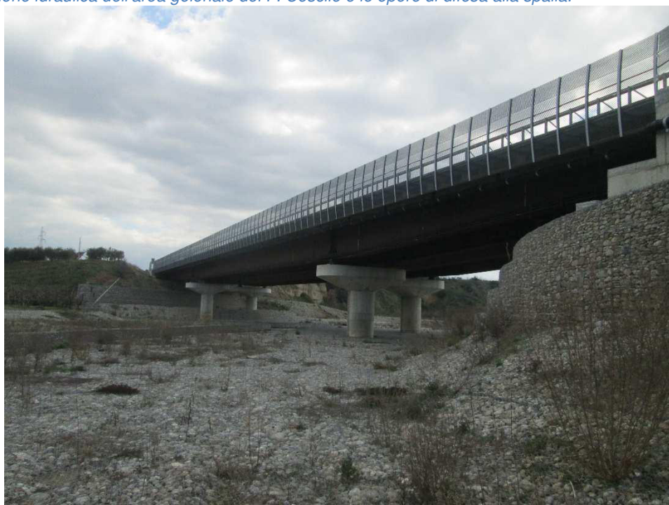
Vista 2 - Nuovo Viadotto Coscile. È possibile osservare la sistemazione idraulica dell'area golenale del F. Coscile e le opere di difesa in corrispondenza delle spalle e delle pile.
