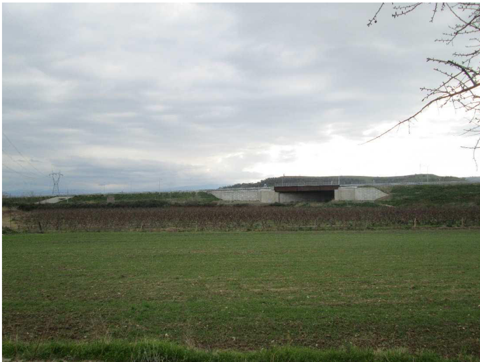
Vista 2 – Zona del Cavalcaferrovia dove si può osservare l'opera terminata L'area limitrofa è rimasta inalterata.
