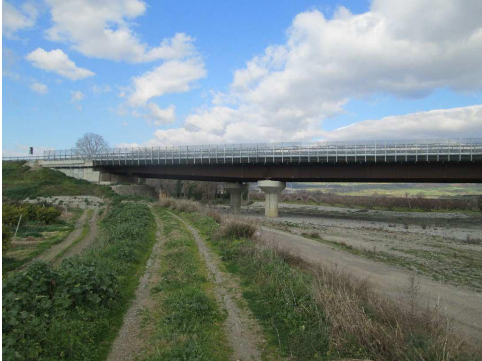
Vista 1 – Zona a valle delle spalle lato Sibari ed adiacente all'area golenale del Fiume Coscile (sponda destra). Si possono osservare le terre rinforzate rinverdite a tergo della spalla del Viadotto.
