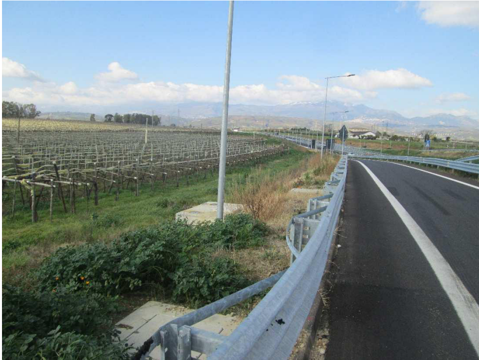
Vista 3 - Rampa D del nuovo svincolo SV02. La sede stradale è stata adeguata al progetto e sono stati installati i nuovi guardarail e l'impianto di illuminazione. Le aree adiacenti alla nuova sede stradale rimangono sostanzialmente immutate
