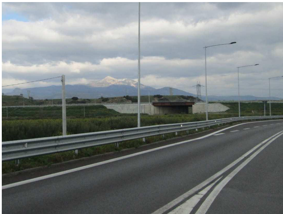
Vista 6 – Immagine d'insieme del Cavalcaferrovia con le terre armate a tergo delle spalle.
