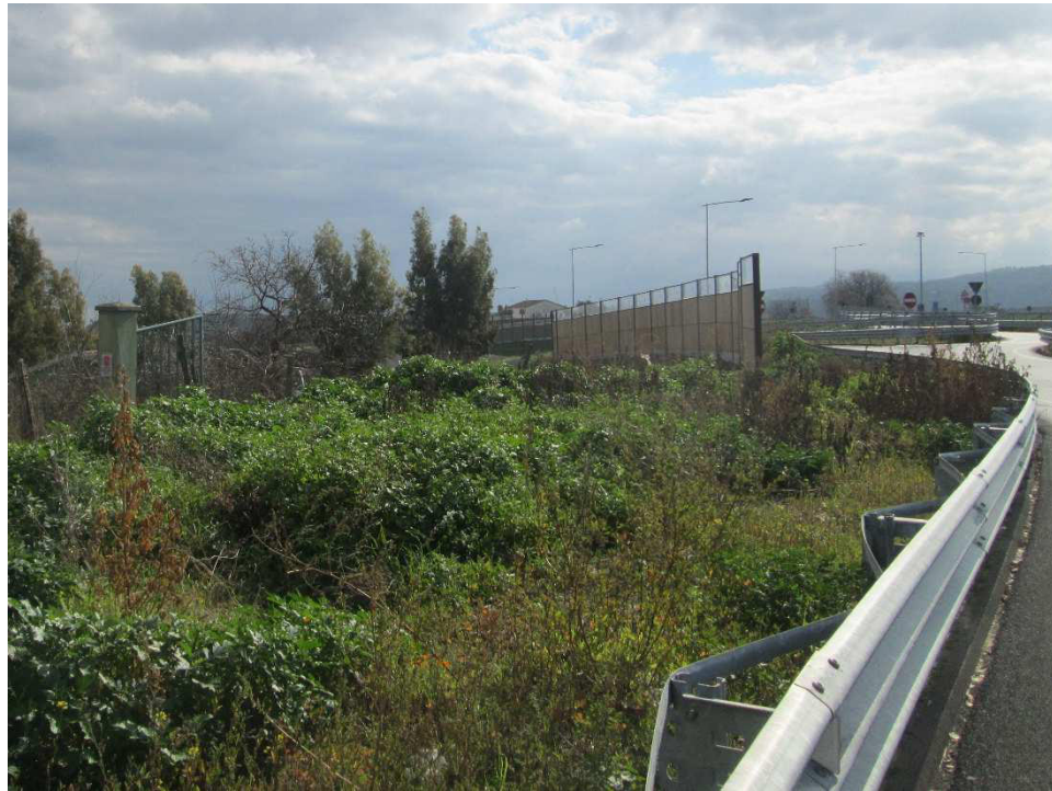
Vista 1 – Rifacimento dell'area di svincolo con la ex SS19, con installazione di nuovi guardrail e barriere fonoassorbenti
