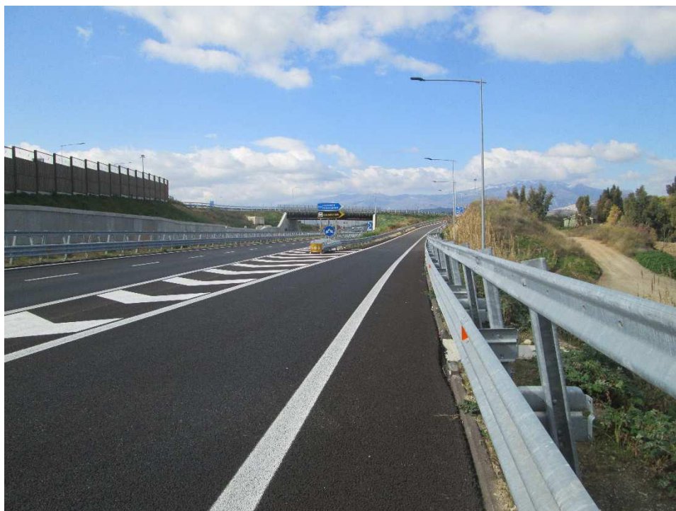
Vista 4 – Nuova sede stradale della SS534 dopo i lavori di ampliamento. Si possono osservare le nuove opere di contenimento del versante, le barriere fonoassorbenti, i guardrail e l'impianto di illuminazione. Sullo sfondo si intravede l'impalcato del nuovo cavalcavia (CV02) della SS19 sulla SS534
