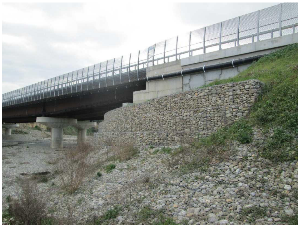
Vista 1 – Impalcato in ferro del nuovo Viadotto Coscile e le barriere in dotazione. È possibile osservare la sistemazione idraulica dell'area golenale del F. Coscile e le opere di difesa alla spalla.
