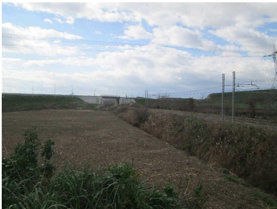
Vista 8 – Sullo sfondo il corpo del rilevato ferroviario che interferisce con il tracciato della SS534
