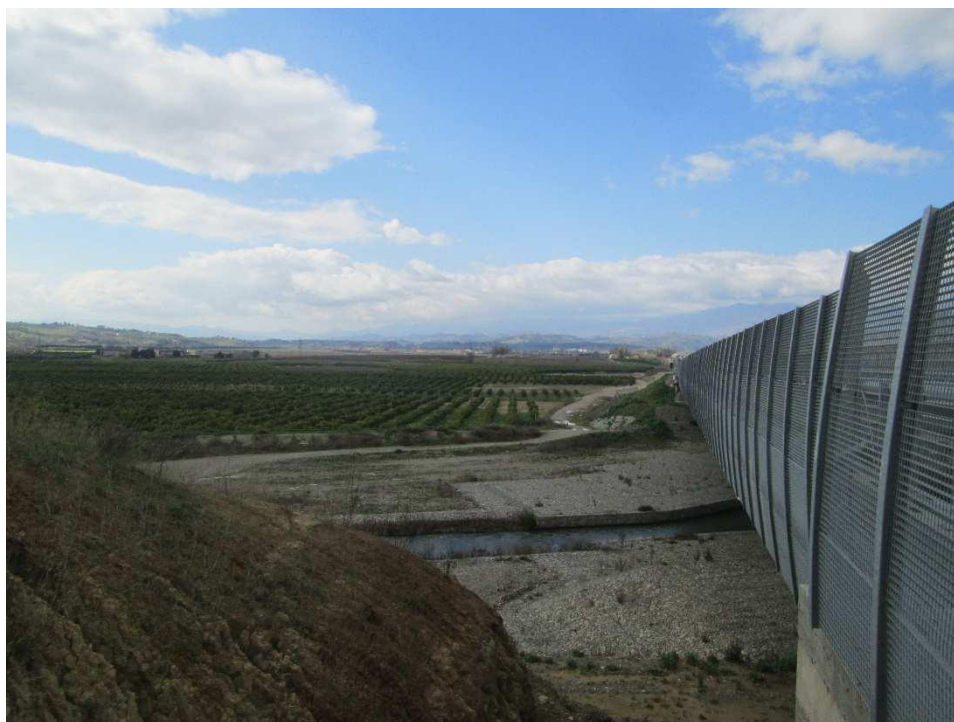
Vista 5 - Punto panoramico della zona sul Fiume Coscile. In primo piano si osserva la sistemazione idraulica dell'area golenale del fiume, sulla destra il nuovo viadotto. Sullo sfondo si intravedono le porzioni di territorio non interessate dall'opera
