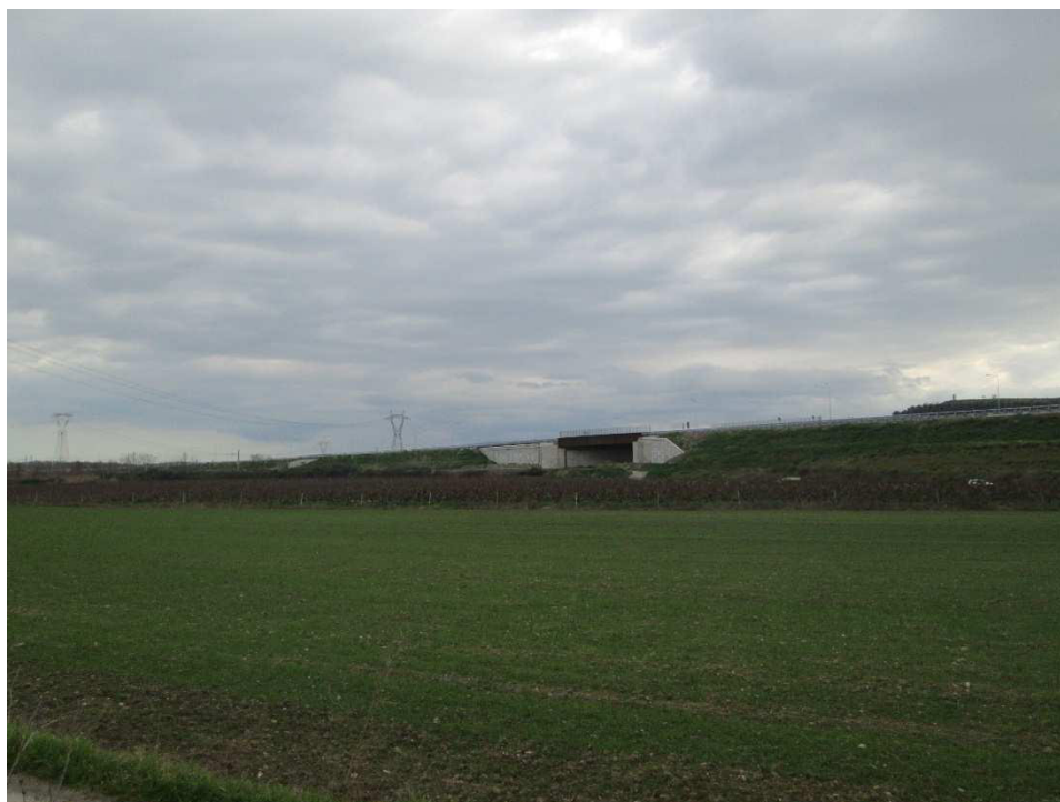
Vista 3 – Vista panoramica della zona sul Cavalcaferrovia dove si può osservare l'opera terminata. L'area limitrofa è rimasta inalterata
