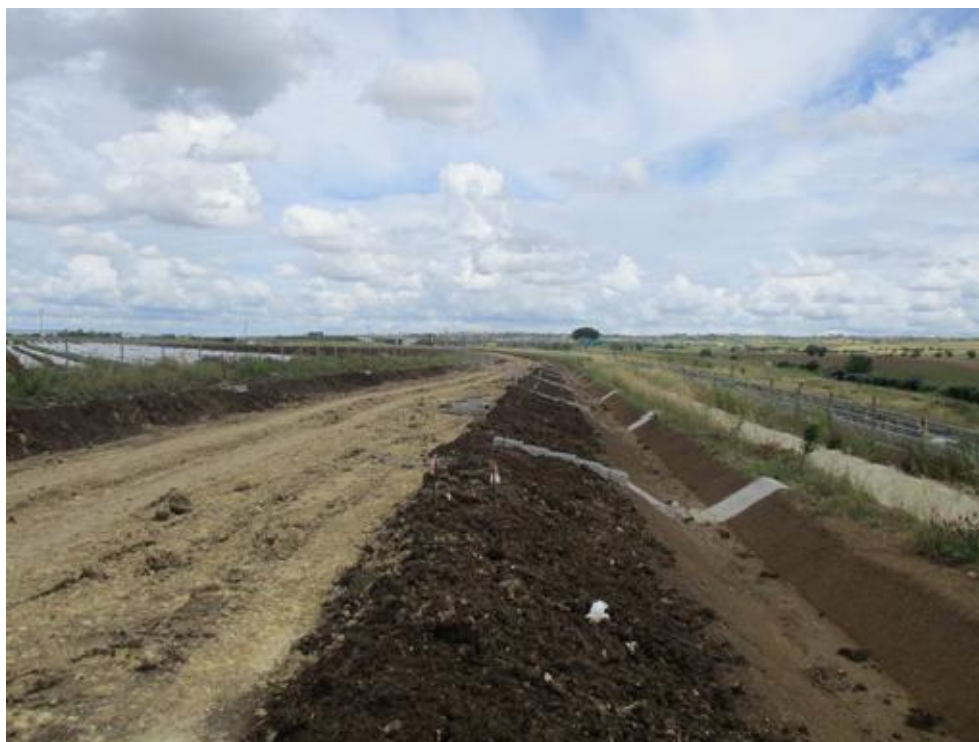
INP 200A - Opere idrauliche – Embrici e rivestimento fossi di guardia in corrispondenza degli embrici in Sx tra sez. 1 e sez. 25
