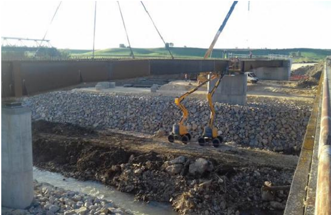
VIP03 Viadotto Mignone – Impalcato in acciaio corten - Varo seconda campata
