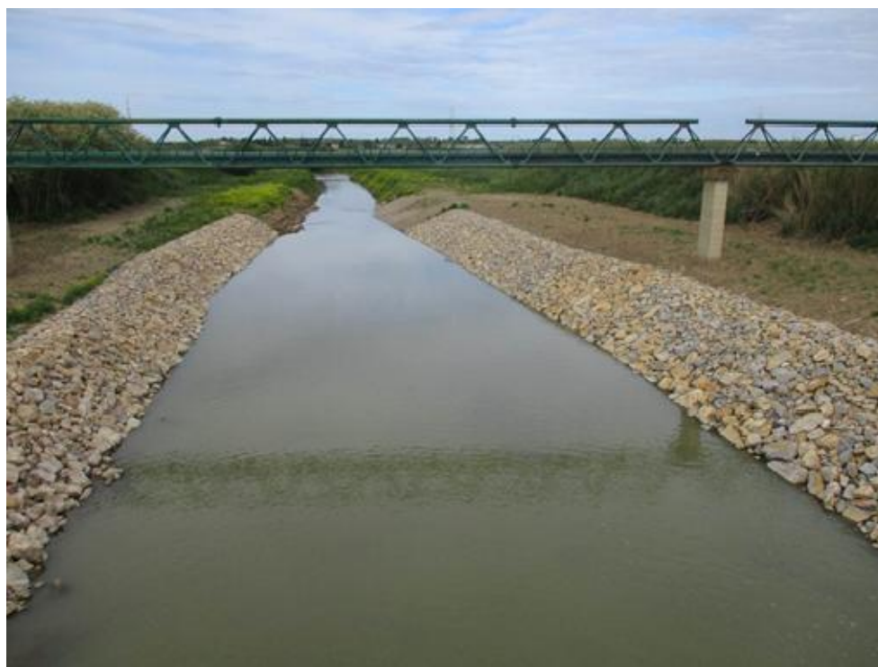
Riprofilatura alveo fiume Mignone – Lato valle ultimata
