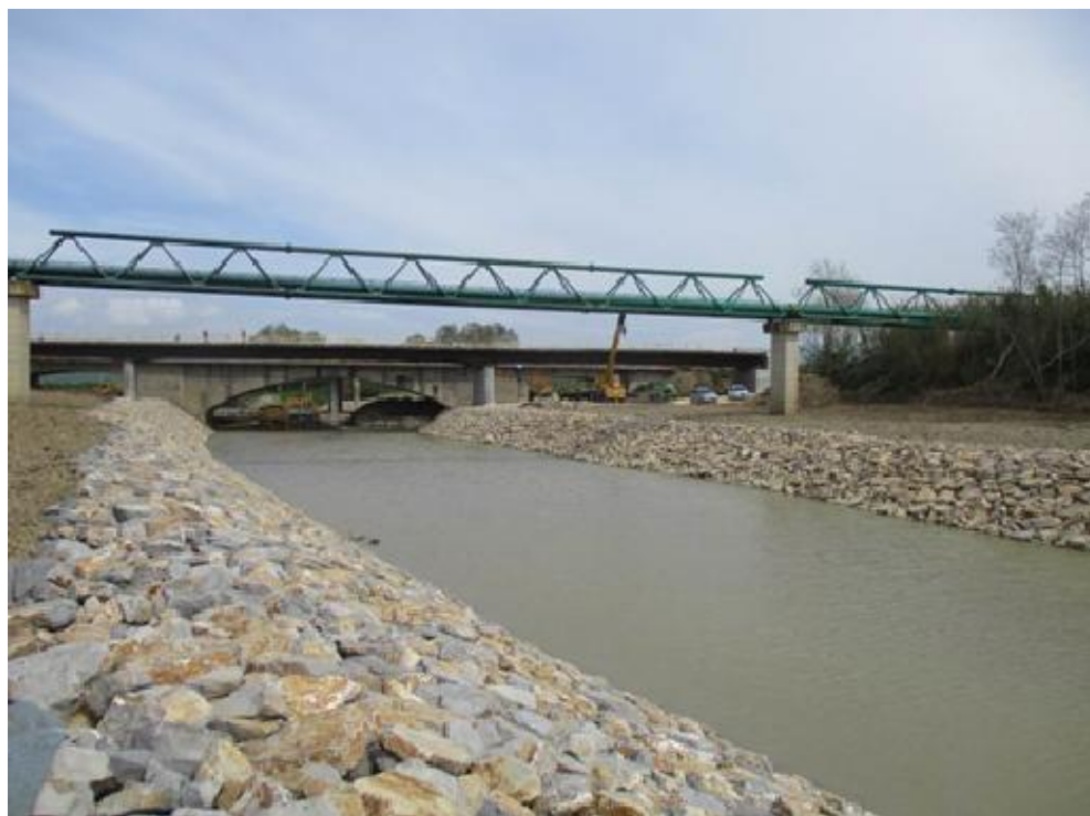
Riprofilatura alveo fiume Mignone – Sistemazione spondale e dragaggio letto del fiume lato valle ultimato a valle del ponte relitto
