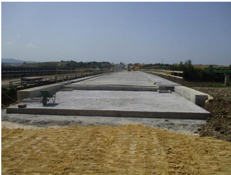
VIP03 Viadotto Mignone – Soletta oscillante spalla A
