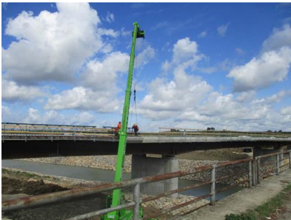
VIP03 Viadotto Mignone – Posa in opera velette, terza campata lato Sx
