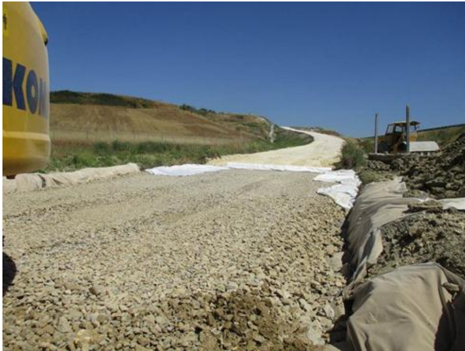
INP 200A - Bonifica in corrispondenza della SP97
