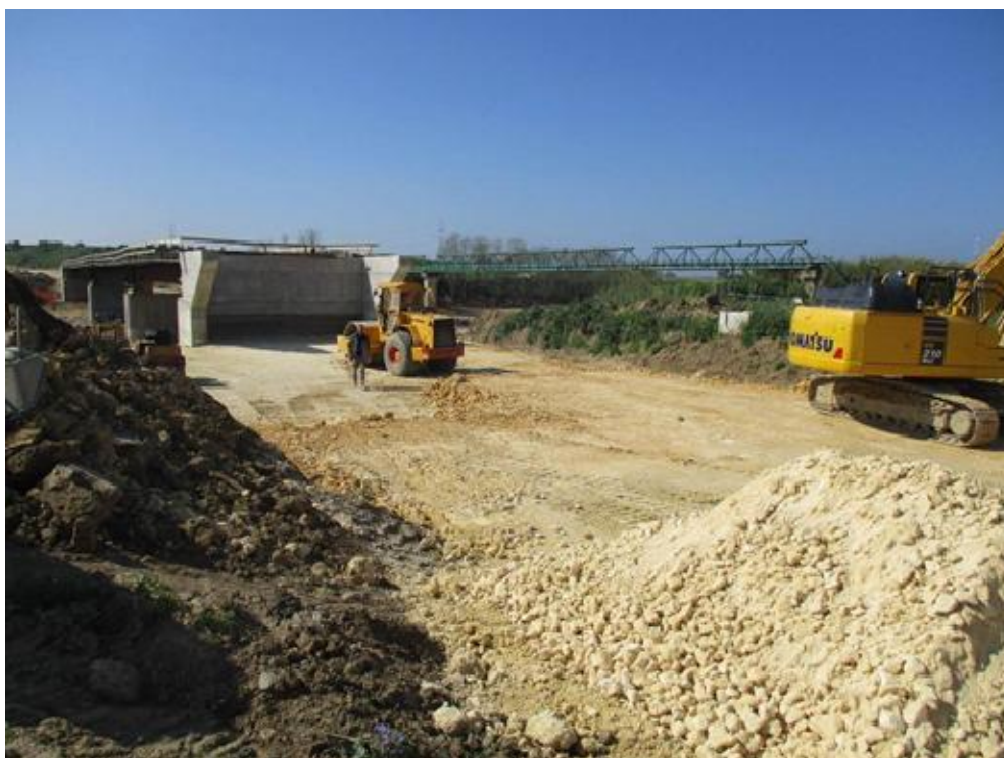
INP 200B Formazione rilevato tra la sez. 26 e la sez. 32
