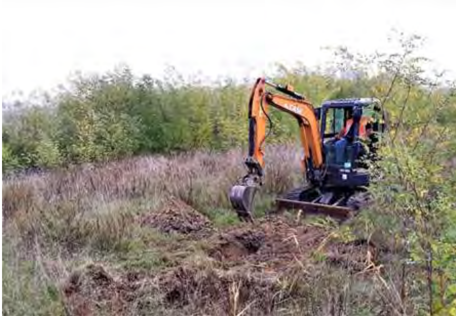
Fig. 35 Fasi di escavazione in sezione e di separazione di terreno vegetale e di terreno destinato alle fasi di campionamento elementare
