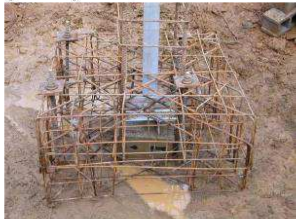
Figura 4-8: Esempio della realizzazione di fondazione con tiranti in roccia
