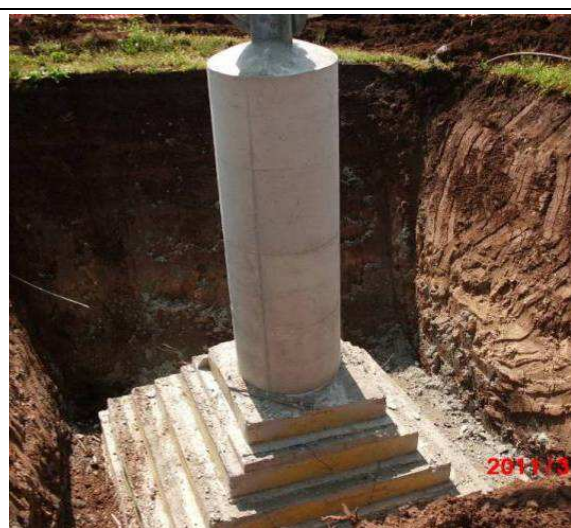
Figura 4-7: Esempio di realizzazione di una fondazione a plinto con riseghe. Nell'immagine di sinistra di può osservare un disegno di progetto mentre nell'immagine di destra la fase di cassatura della fondazione
