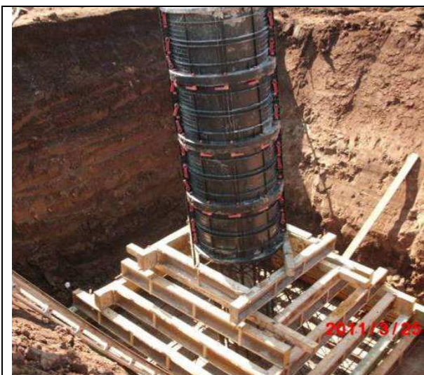
Figura 4-7: Esempio di realizzazione di una fondazione a plinto con riseghe. Nell'immagine di sinistra di può osservare un disegno di progetto mentre nell'immagine di destra la fase di cassatura della fondazione
