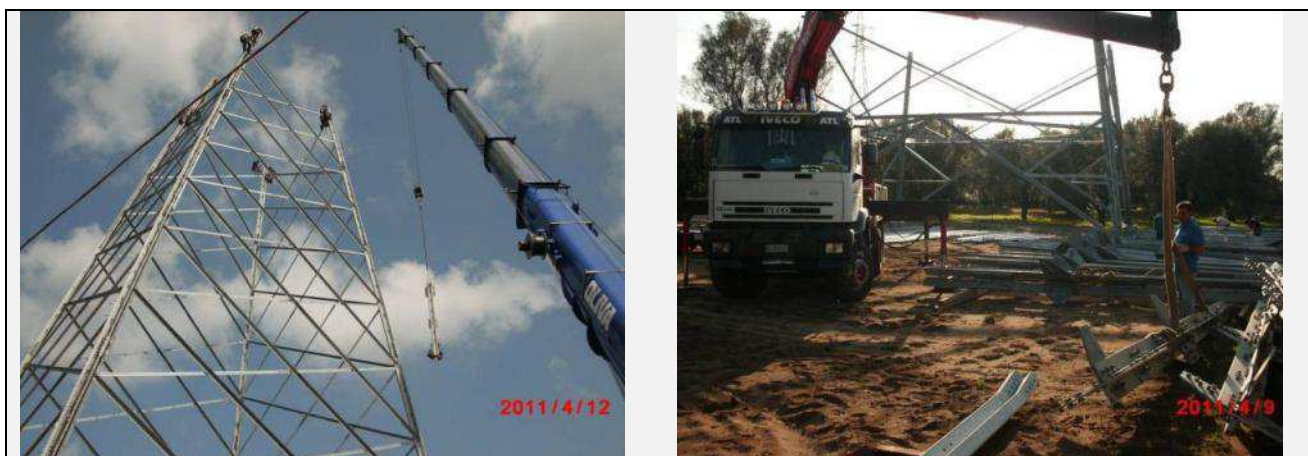
Figura 4-12: Fasi di montaggio sostegno a traliccio
