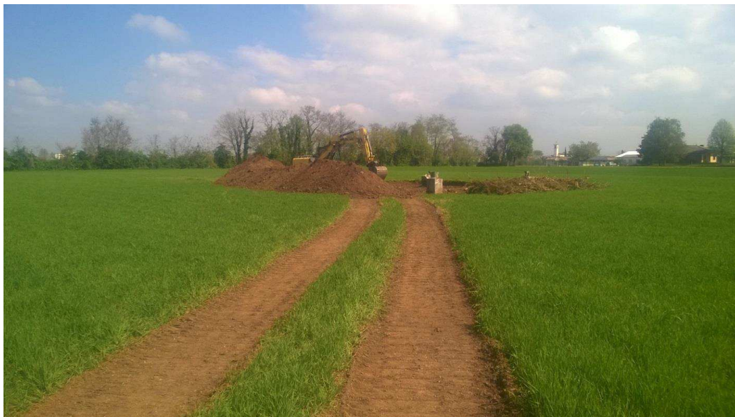
Figura 4-14: Esempio di pista temporanea su terreno agricolo
