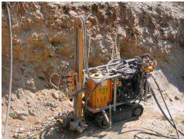
Figura 4-8: Esempio della realizzazione di fondazione con tiranti in roccia
