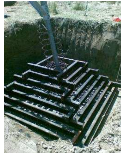
Figura 4-7: Esempio di realizzazione di una fondazione a plinto con riseghe. Nell'immagine di sinistra di può osservare un disegno di progetto mentre nell'immagine di destra la fase di cassatura della fondazione
