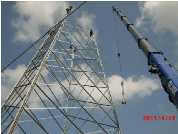
Figura 9-9 Fasi di montaggio sostegno a traliccio
