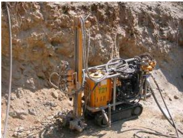
Figura 9-3 Esempio di fondazione con tiranti in roccia
