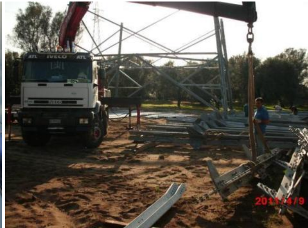
Figura 9-9 Fasi di montaggio sostegno a traliccio
