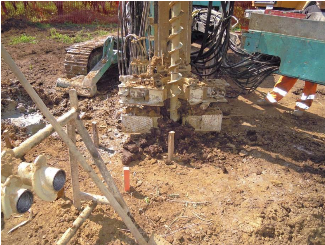
Figura 9-8: Macchina operatrice per la realizzazione di micropali tubfix; sistema di scavo mediante trivella elicoidale
