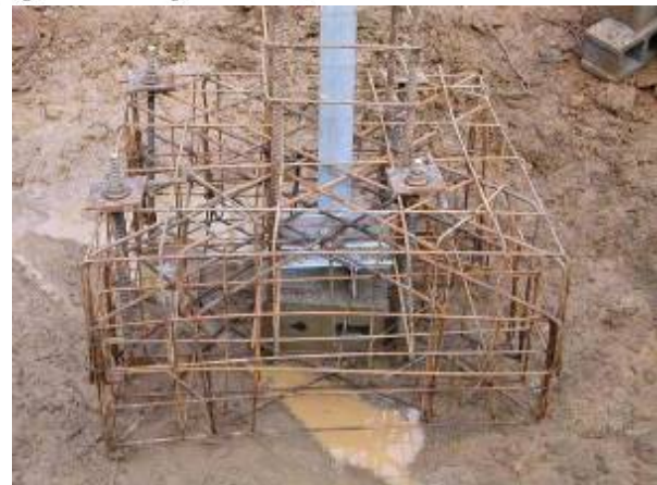
Figura 9-3 Esempio di fondazione con tiranti in roccia
