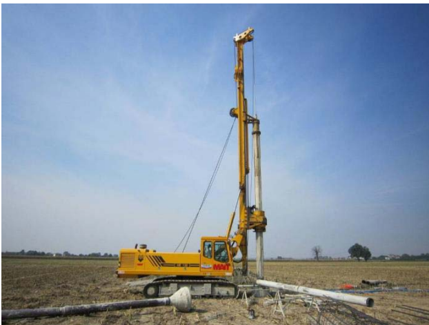
Figura 9-5 : Macchina operatrice per la realizzazione di pali trivellati
