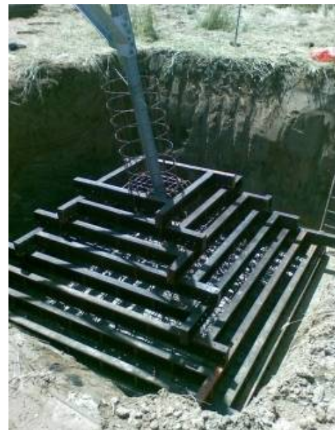
Figura 9-2 Esempio di realizzazione di una fondazione a plinto con riseghe. Nell'immagine di sinistra di può osservare un disegno di progetto mentre nell'immagine di destra la fase di cassetatura della fondazione
