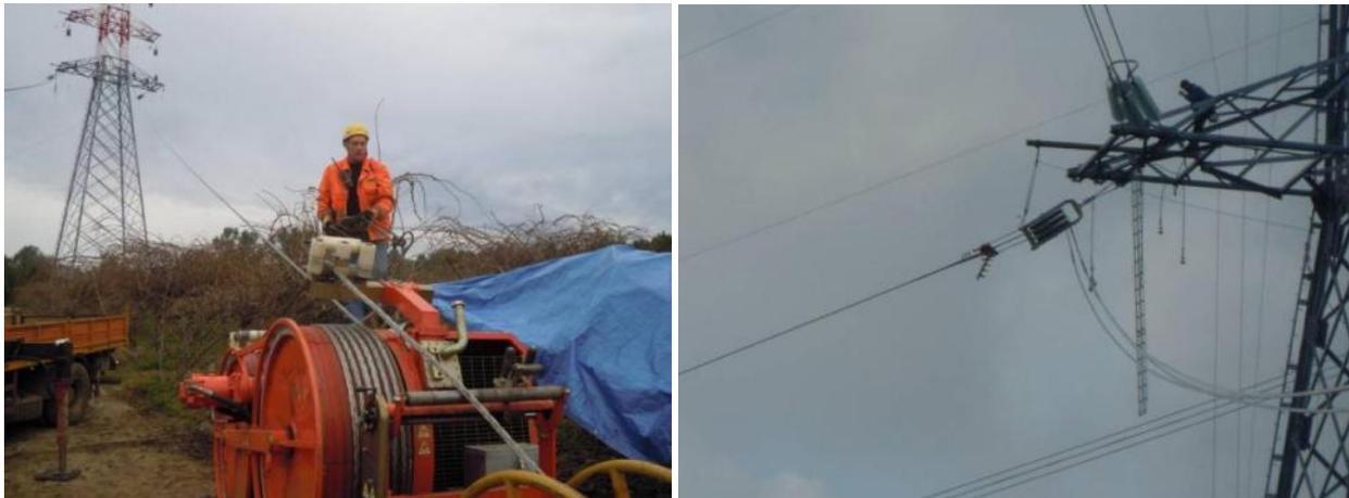
**Figura 3.3-19 Fasi di tesatura della linea elettrica**
