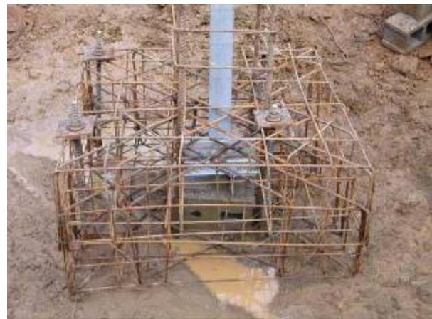
**Figura 3.3-11: Esempio di fondazione con tiranti in roccia**
