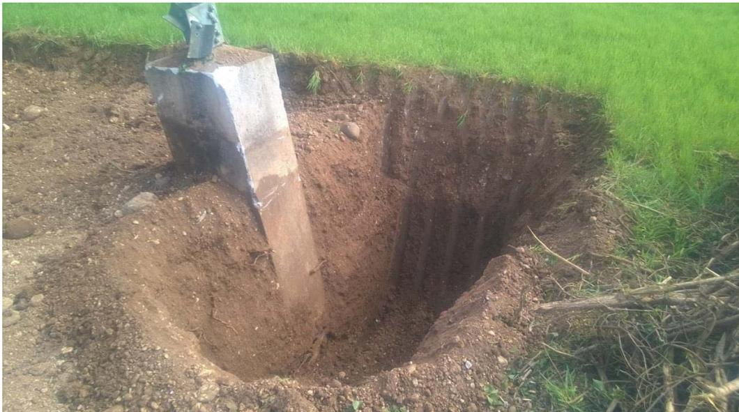
**Figura 3.3-22: Esempio di rimozione della fondazione superficiale di un sostegno 220 kV**
