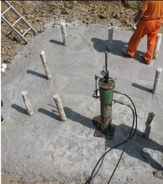
Realizzazione di micropali tipo tubfix per un sostegno a traliccio; si possono osservare i 9 micropali già realizzati ed iniettati; in questa fase, prima dell'armatura e cassetatura del plinto di fondazione, si sta eseguendo una prova di tenuta del micropalo allo strappamento, al fine di verificare la corretta progettazione e realizzazione dello stesso
