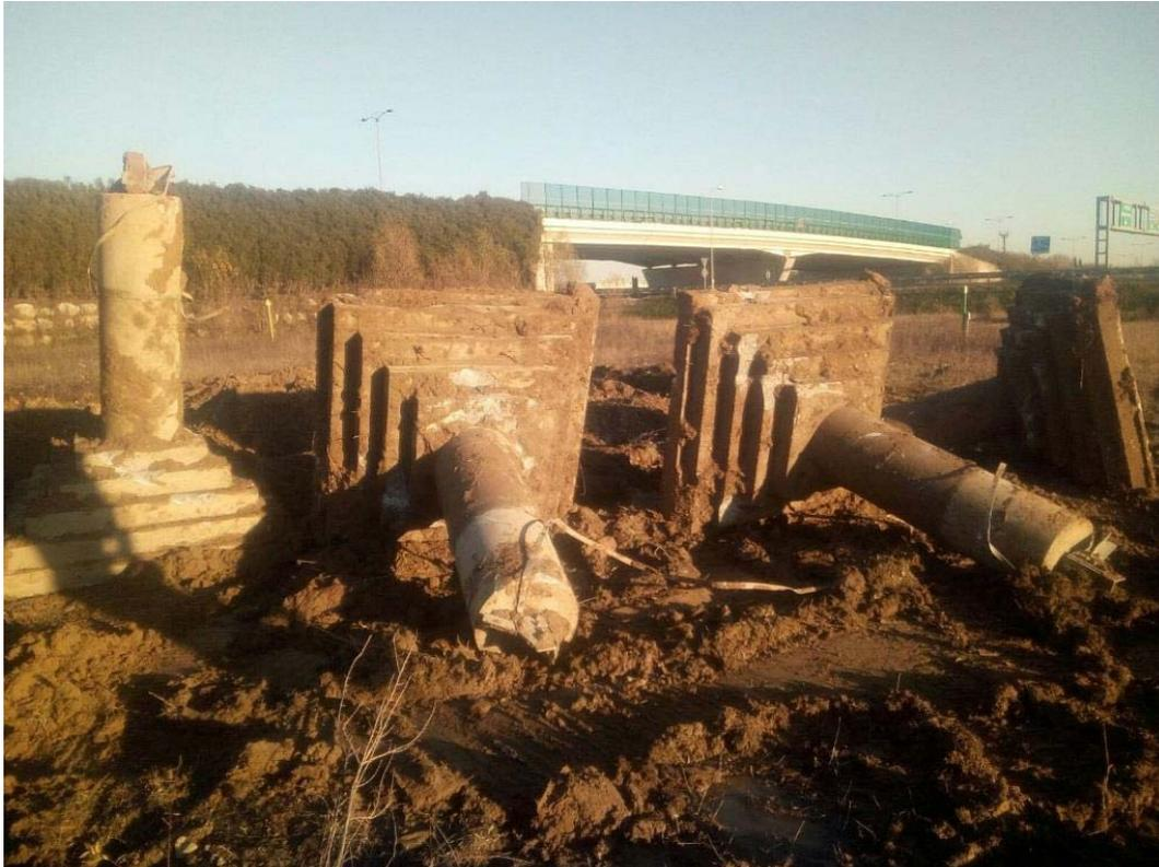
**Figura 3.3-21: Esempio di rimozione della fondazione superficiale di un sostegno 220 kV**
