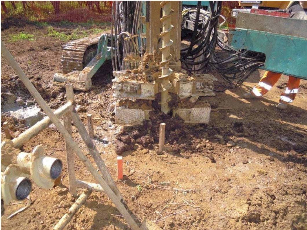
**Figura 3.3-16** *Macchina operatrice per la realizzazione di micropali tubfix; sistema di scavo mediante trivella elicoidale*
