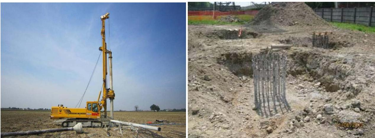
**Figura 3.3-13: Macchina operatrice per la realizzazione di pali trivellati**
