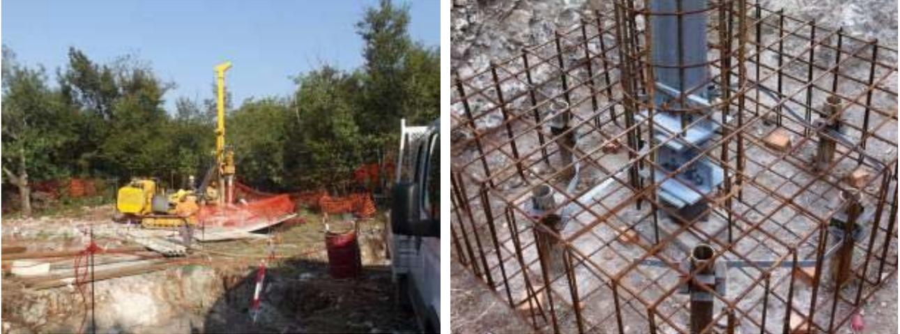
Esempio di realizzazione di una fondazione su micropali tipo tubfix. Nell'immagine di destra si può notare il particolare del raccordo tra i tubolari metallici dei micropali con l'armatura del plinto di fondazione; al centro del plinto si nota il moncone del sostegno (elemento di raccordo tra il sostegno e la fondazione) il quale viene annegato nella fondazione stessa
