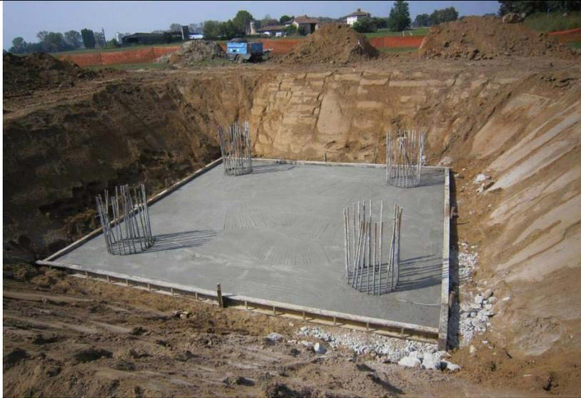
Realizzazione di una fondazione su pali trivellati per un sostegno monostelo. Nell'immagine si può osservare una fondazione in fase di realizzazione. Si possono distinguere facilmente i quattro pali trivellati già realizzati e gettati (si osservano le "ripresе" delle quattro gabbie metalliche) ed il piano di "magrone" sul quale impostare il monoblocco in cls
