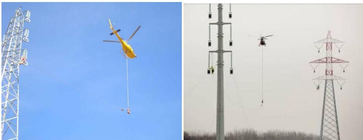
**Figura 3.3-18 Utilizzo dell'elicottero per la stesura della fune pilota. Si noti il particolare delle carrucole.**
