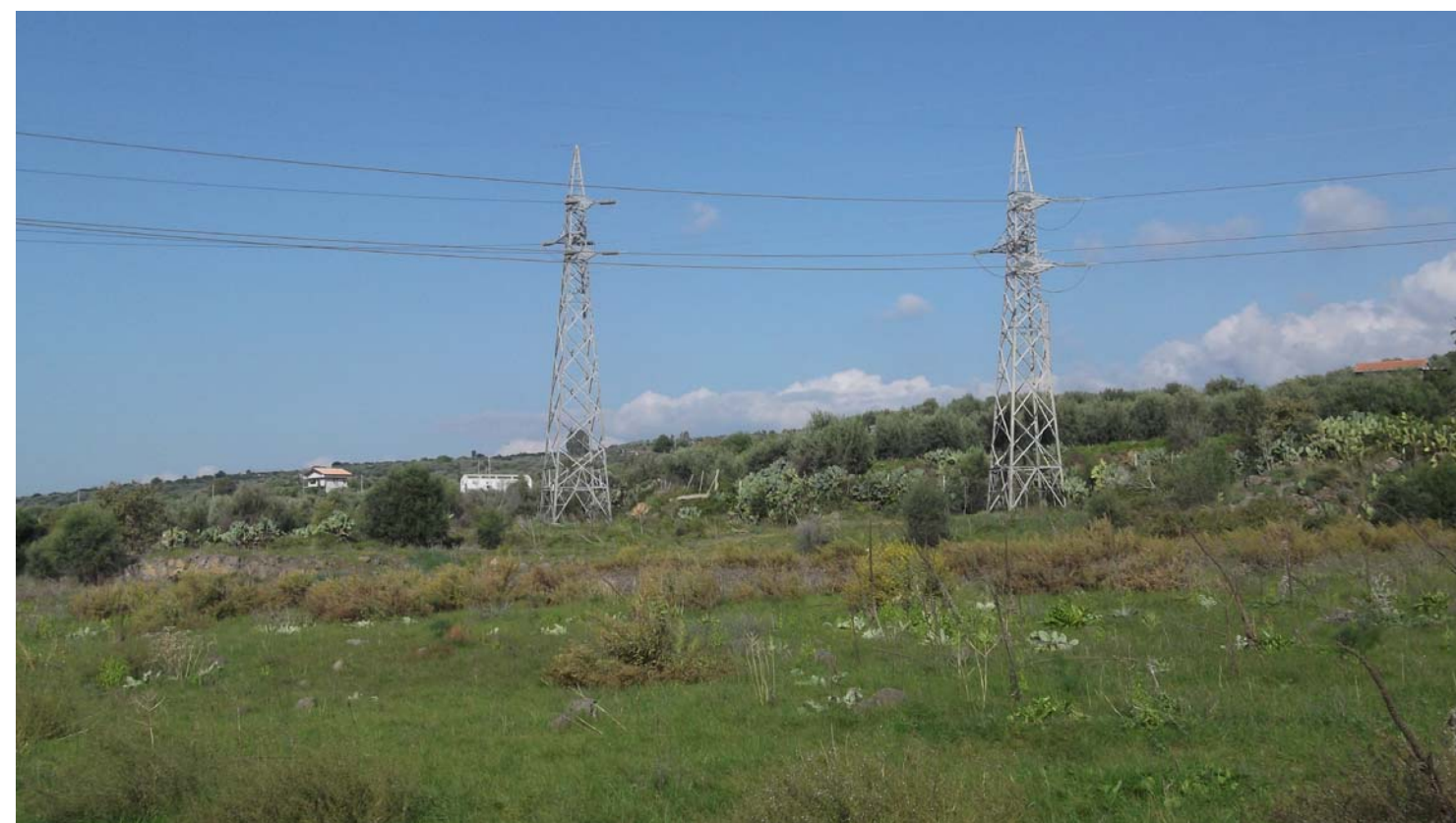
Foto 02 - Visuale verso i sostegni 65 (da demolire) e 65 -1
