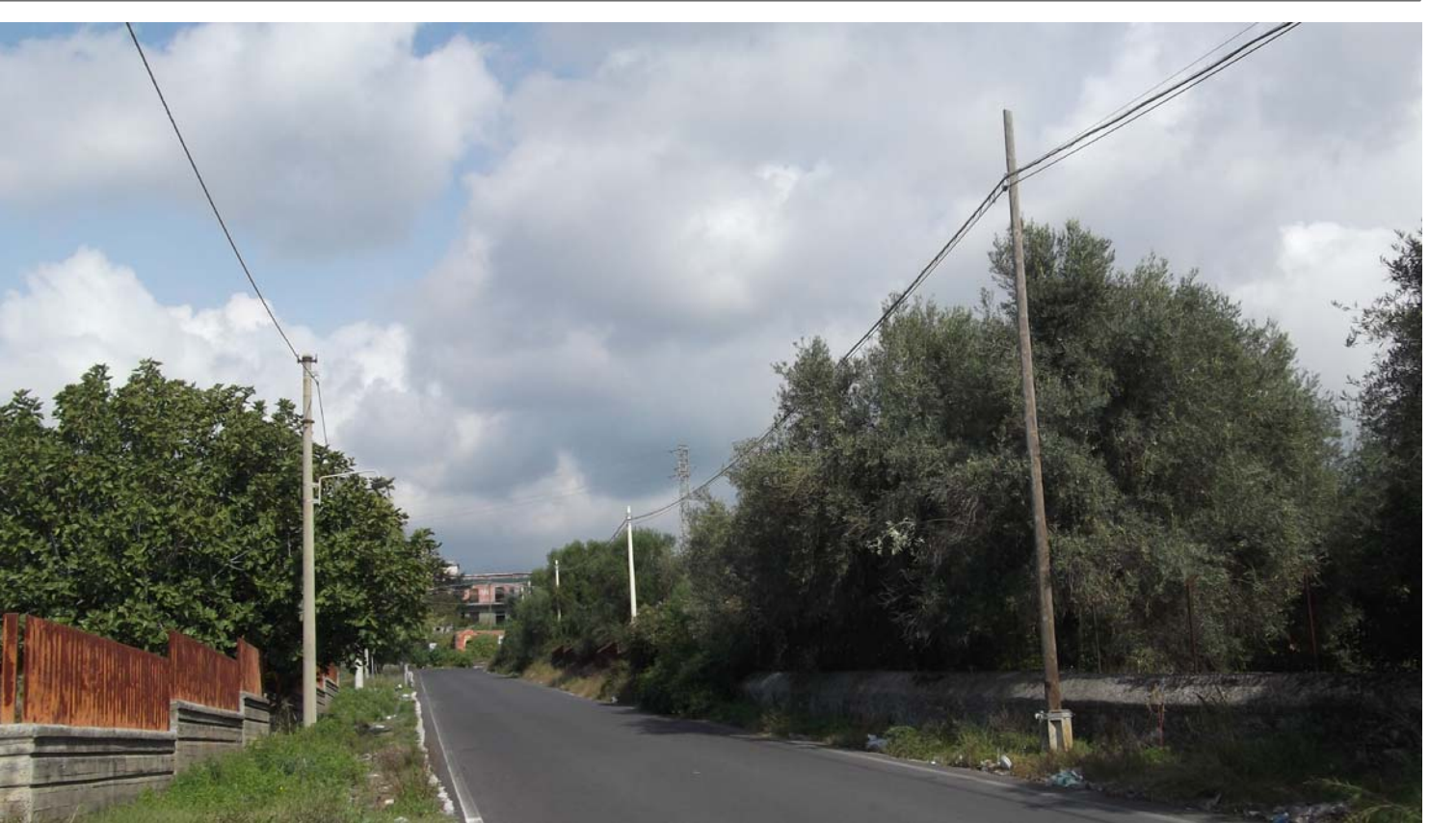
Foto 10 - Visuale da S.P.184 verso sostegno 9
