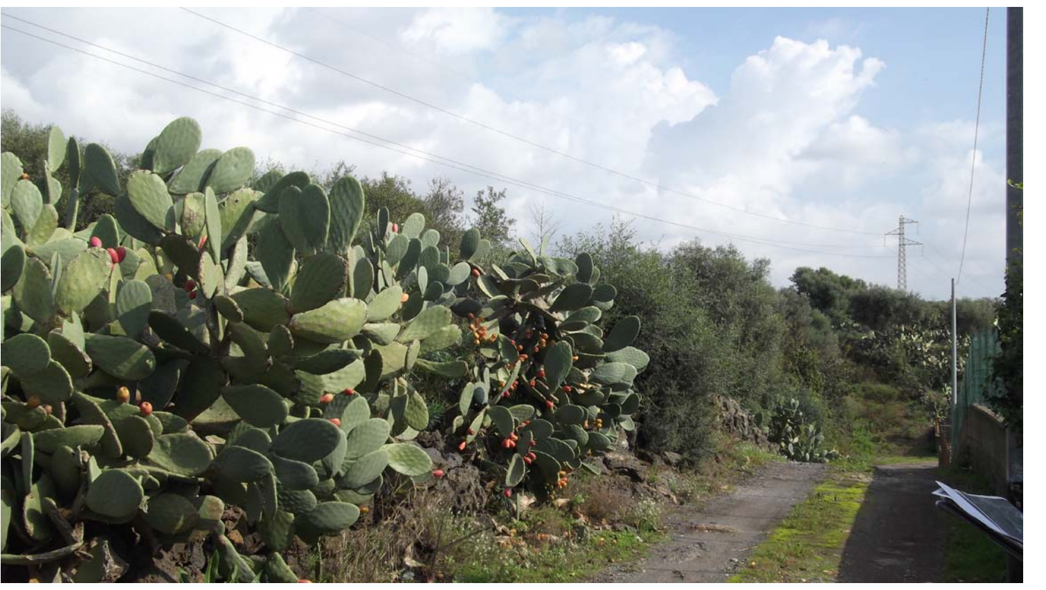
Foto 15 - Visuale da S.C. Palazzolo verso sostegno 13
