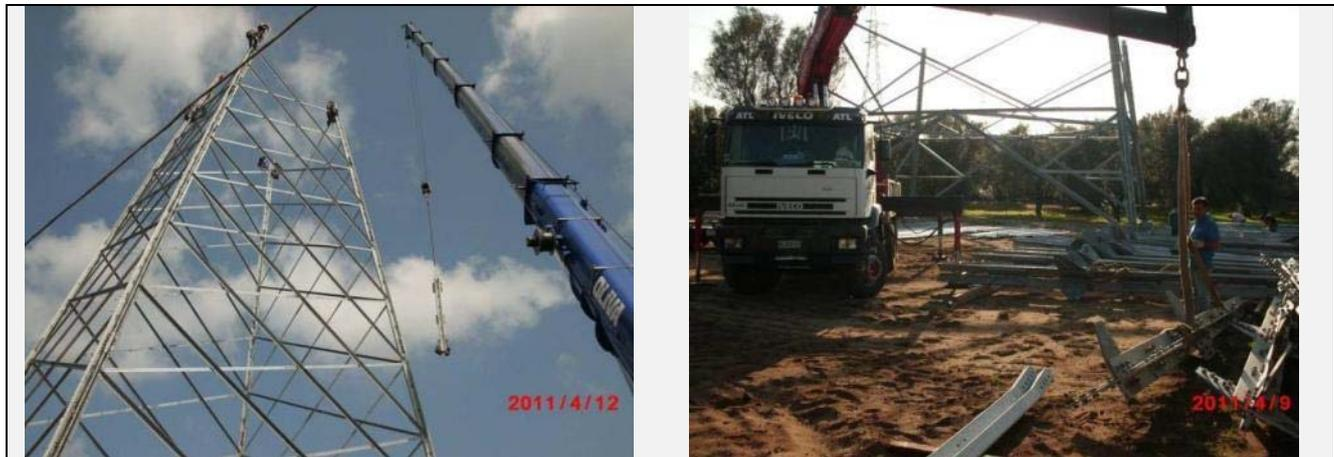
**Figura 3-4 Fasi di montaggio sostegno a traliccio**
