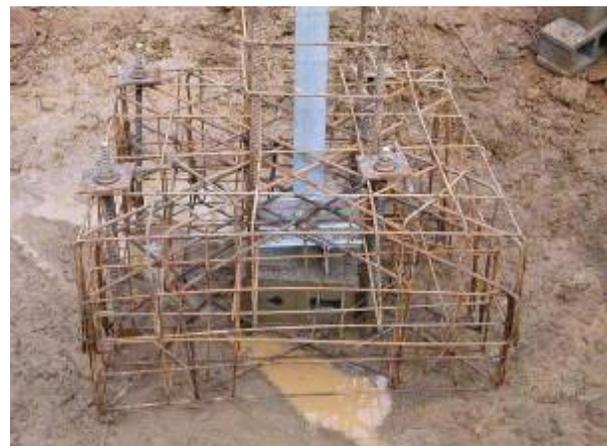
**Figura 2-5: Esempio di fondazione con tiranti in roccia**
