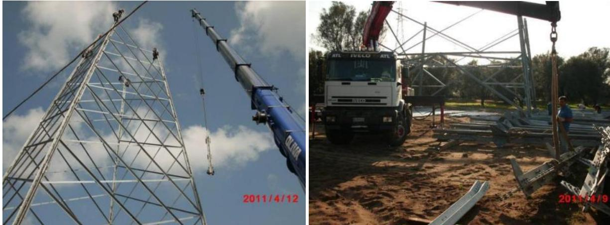
**Figura 2-9** Fasi di montaggio sostegno a traliccio
