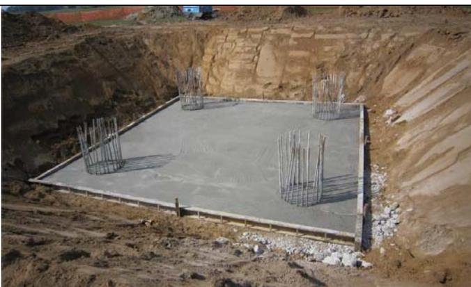
Realizzazione di una fondazione su pali trivellati per un sostegno monostelo. Nell'immagine si può osservare una fondazione in fase di realizzazione. Si possono distinguere facilmente i quattro pali trivellati già realizzati e gettati (si osservano le "ripresе" delle quattro gabbie metalliche) ed il piano di "magrone" sul quale impostare il monoblocco in cls
