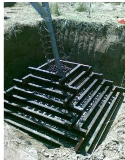
**Figura 2-4 Esempio di realizzazione di una fondazione a plinto con riseghe. Nell'immagine di sinistra di può osservare un disegno di progetto mentre nell'immagine di destra la fase di cassetatura della fondazione**
