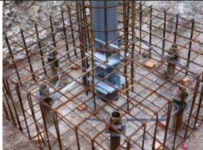
Esempio di realizzazione di una fondazione su micropali tipo tubifix. Nell'immagine di destra si può notare il particolare del raccordo tra i tubolari metallici dei micropali con l'armatura del plinto di fondazione; al centro del plinto si nota il moncone del sostegno (elemento di raccordo tra il sostegno e la fondazione) il quale viene annegato nella fondazione stessa
