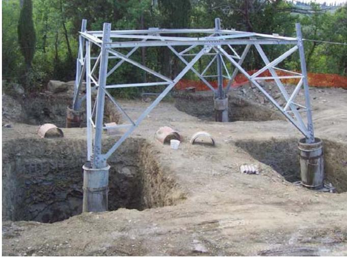
Realizzazione di fondazioni superficiali tipo CR per un sostegno a traliccio. Nell'immagine si possono osservare le quattro buche, la base del sostegno collegata alla fondazione tramite i "monconi" ed i casseri utilizzati per i quattro "colonnini".
