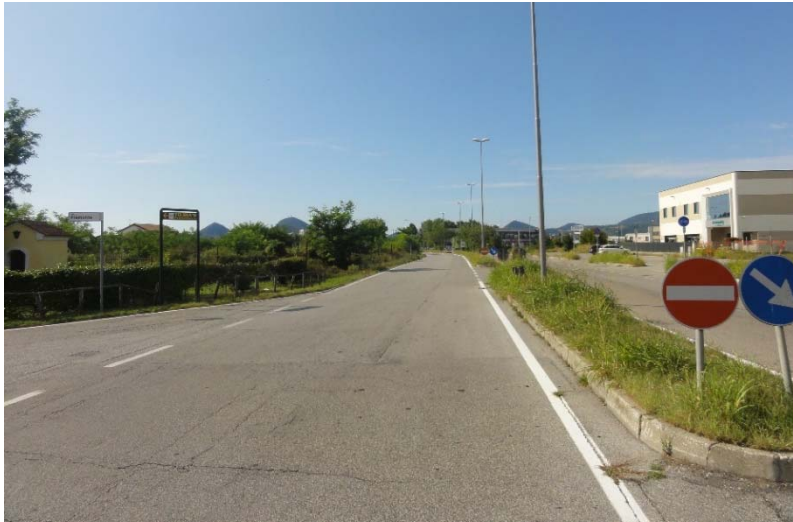
Foto 7: Viabilità interna all'area industriale di Monselice interessata dalla posa della condotta.
