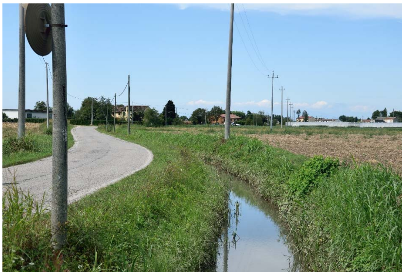
Foto 5: Via Medaglino interessata dalla posa della tubazione.
