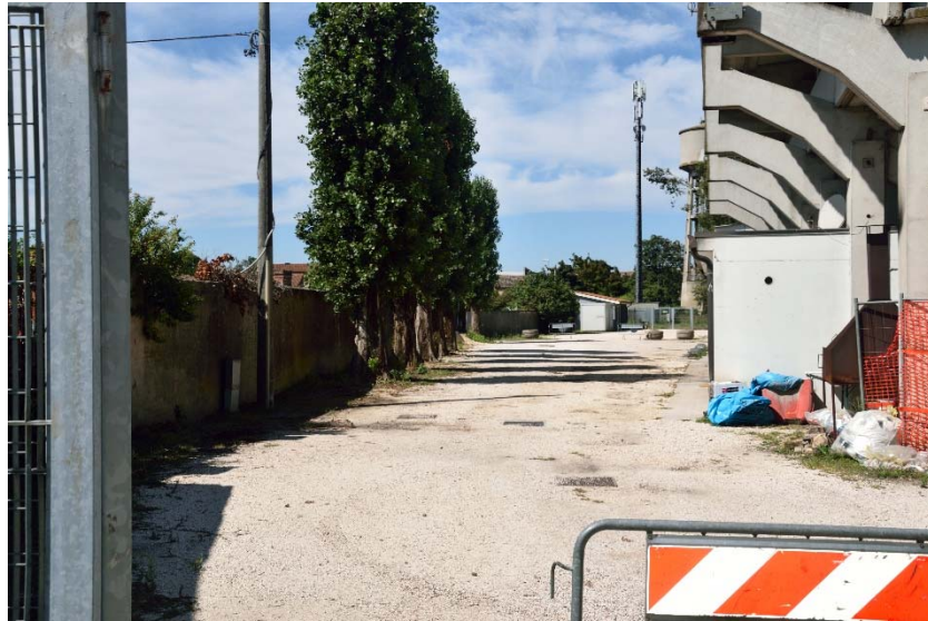
Foto 3: Ultimo tratto di condotta nell'area del campo sportivo verso il serbatoio di Montagnana esistente
