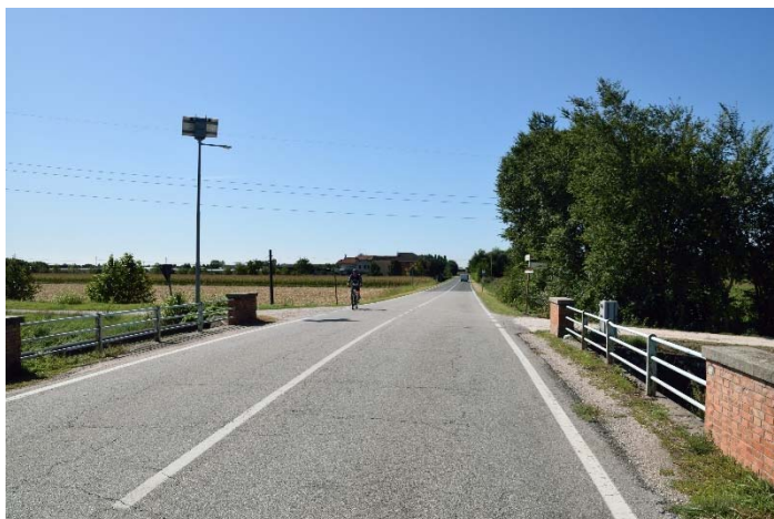
Foto 1: S.P. n. 19 - Stradona interessata dalla posa della condotta.
