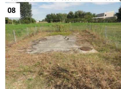
Vista verso Est - Fine Condotta
