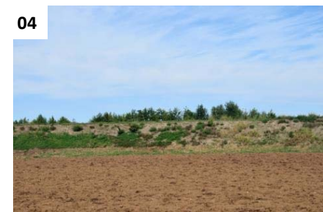
Vista verso Nord (Argine Fiume Frassine)
