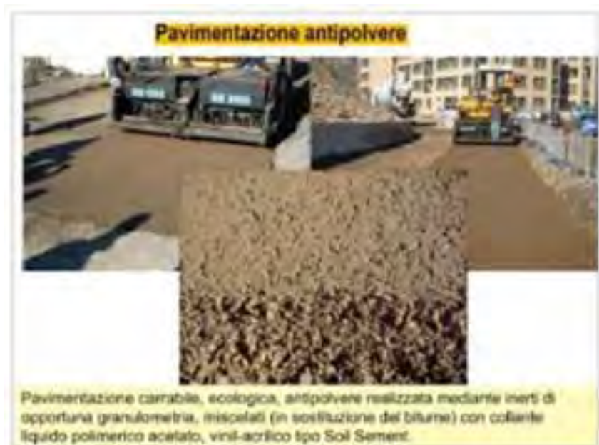
Figura 32: Pavimentazione carrabile ecologica
