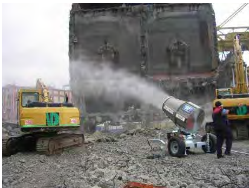
Figura 33: Nebulizzatore per abbattimento polveri.
