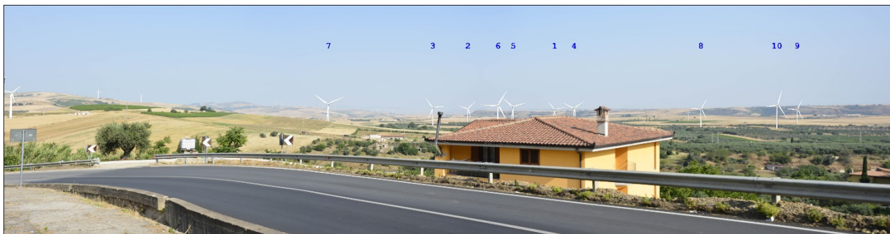
Figura 11: Stato dei luoghi post operam
