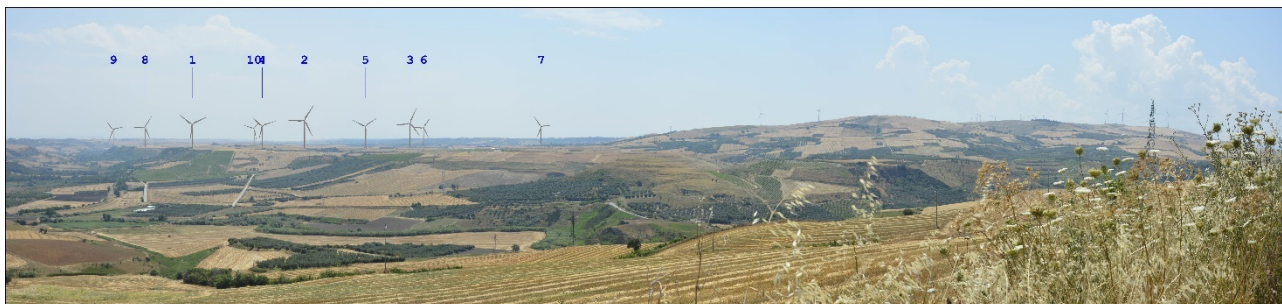
Figura 15 - Stato dei luoghi post operam
