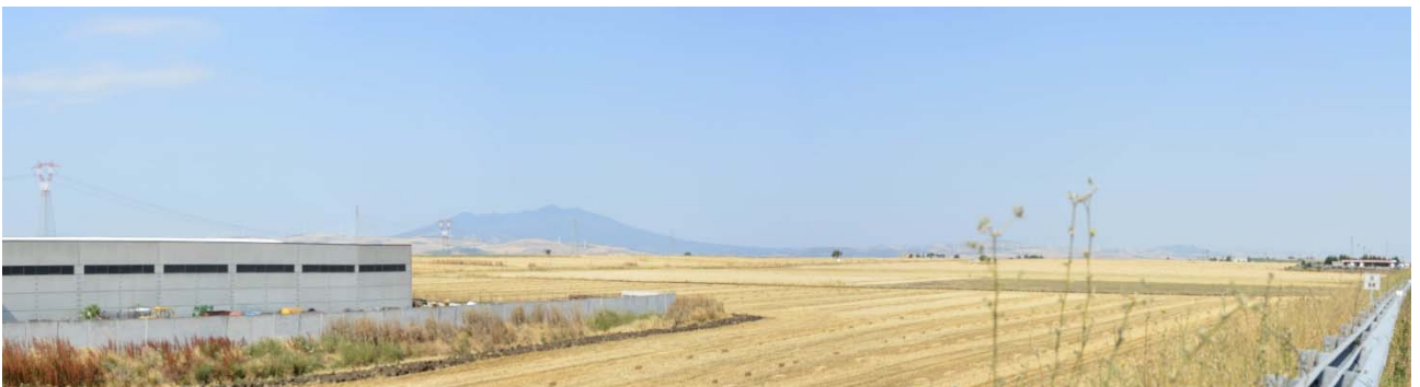
Figura 7: Stato dei luoghi in corrispondenza del punto di ripresa fotografica E
