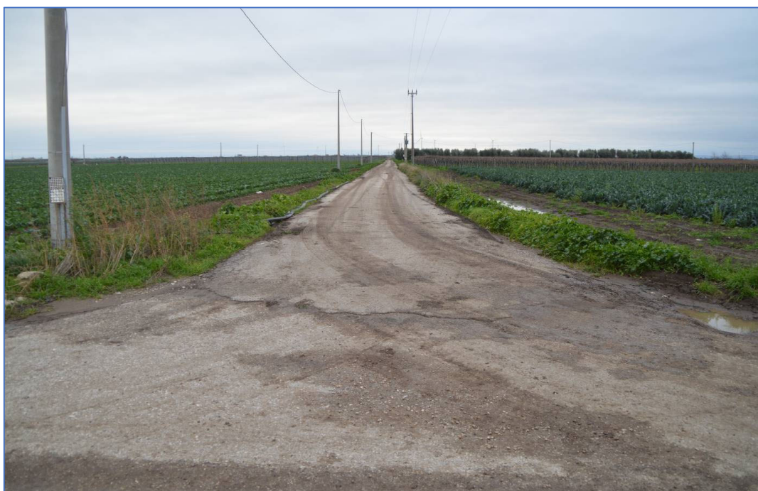
Figura 3: Il percorso del cavidotto interno tra gli aerogeneratori 10 e 9 vista da nord, strada vicinale Ortona – Stornara – Regio Tratturo Ponte di Bovino – Cerignola, verso la strada vicinale Novelli
