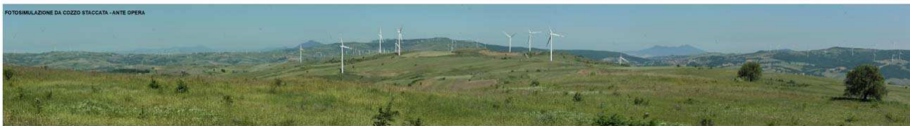
Vista da Cozzo Staccata – Ante Operam
