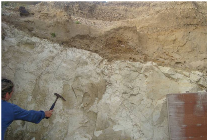
Figura 18 – Appoggio discordante delle Sabbie e ghiaie di Messina sui Trubi. Loc. a nord-ovest di Paradiso.
